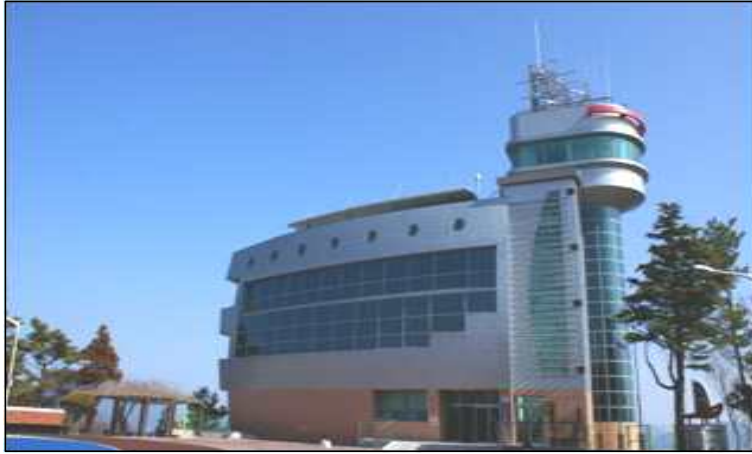
[그림 1] 거북선 모양의 여수 VTS('07.7신축, 3층 건물, 연면적 1,191㎡)
