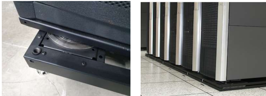
<그림 2> 면진테이블 설치 사례
