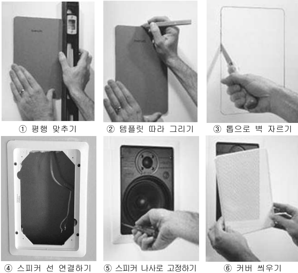
[그림 4-38] Wall Speaker 설치
