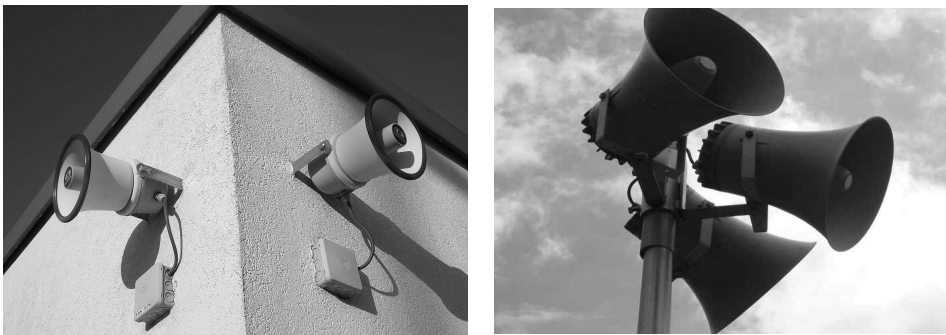
[그림 3-29] Horn Speaker 설치사례(예시)
