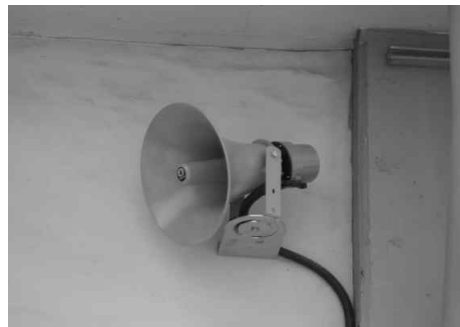
④ Horn Speaker 설치 완료
