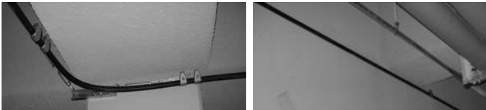
[그림 4-77] 방사형 및 누설 동축케이블 포설
