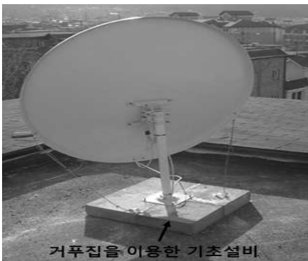
① 거푸집을 이용한 기초설치
