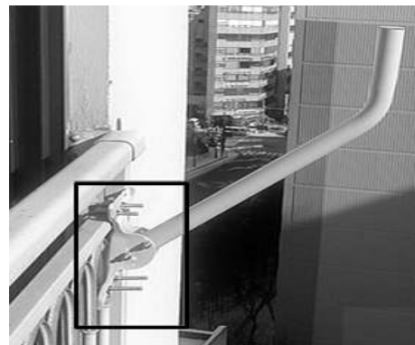
② 지지대 설치
