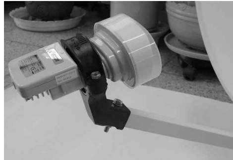
② LNB홀더 및 LNB설치
