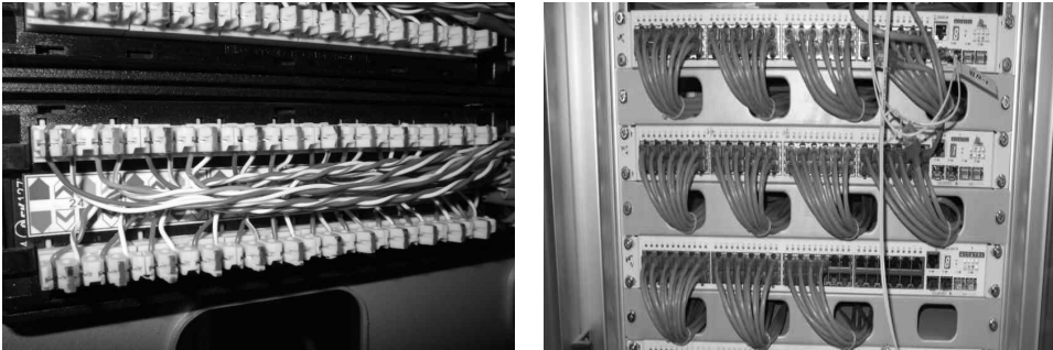
[그림 4-72] 패치패널 설치(예시)
