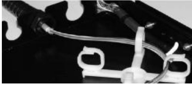
[그림 4-57] FDF 설치 (② 케이블 고정)
