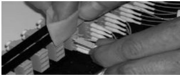
[그림 4-61] FDF 설치 (⑥ 어댑터 연결)
