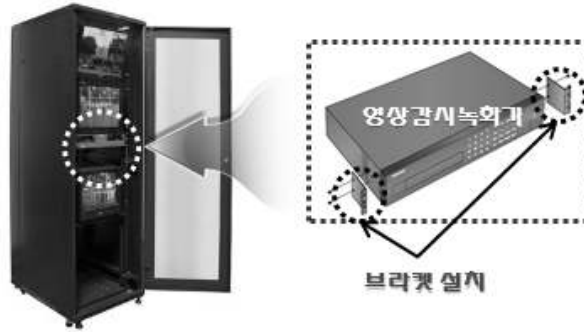
[그림 4-37] 영상감시 녹화기 설치(Rack설치 예시)
