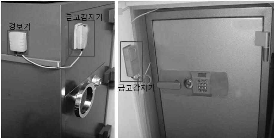
[그림 4-12] 금고 감지기 설치사례(예시)
