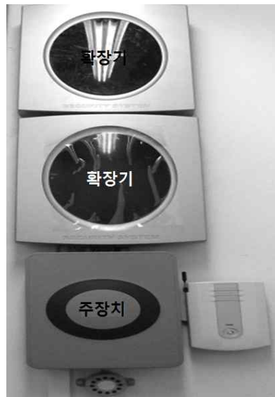
[그림 4-52] 주장치 및 감지기 확장기 설치사례(예시)
