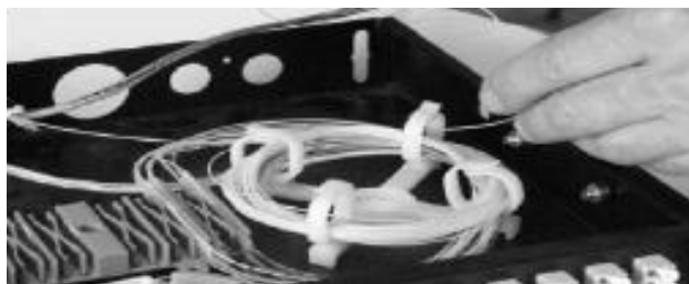
[그림 4-59] FDF 설치 (④ 고정 고리에 고정)
