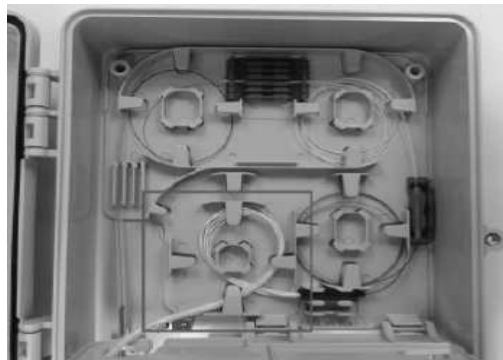
[그림 4-69] 광단자함 설치 (⑤ RN 코드 부분 트레이에 정리)
