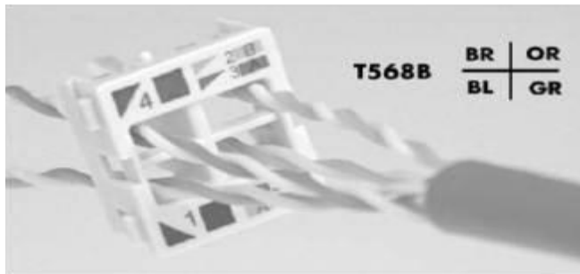
[그림 4-80] UTP Module 설치 (③ 페어별로 끼움)
