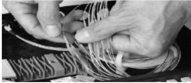
[그림 4-63] FDF 설치 (⑧ 케이블 정리)
