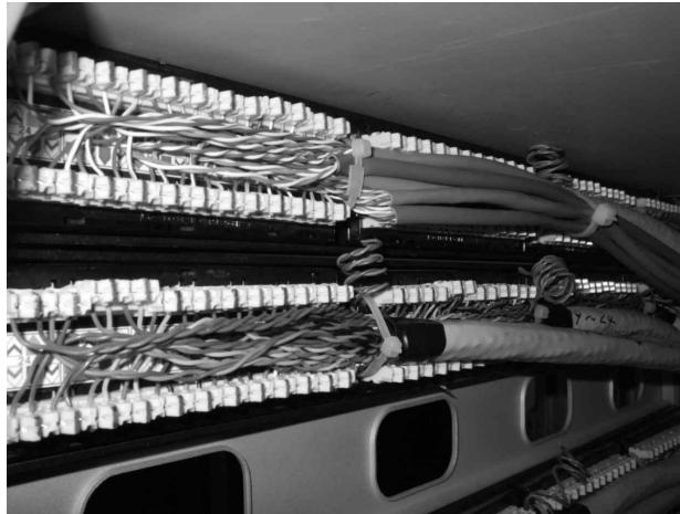
[그림 4-77] 패치패널 설치 (⑤ 케이블 고정)
