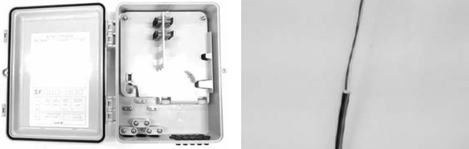
[그림 4-65] 광단자함 설치 (① 광단자함 및 광케이블 준비)
