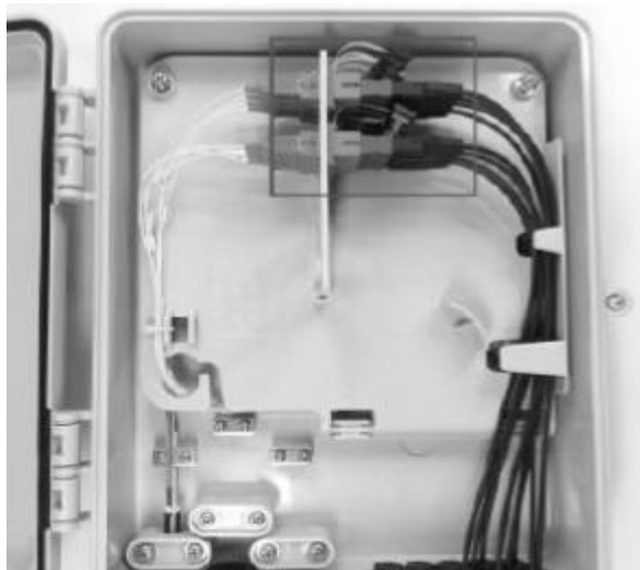
[그림 4-71] 광단자함 설치 (⑦ 광 옥외선 연결)
