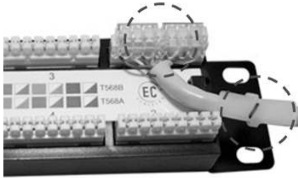
[그림 4-76] 패치패널 설치 (④ 케이블 마킹)
