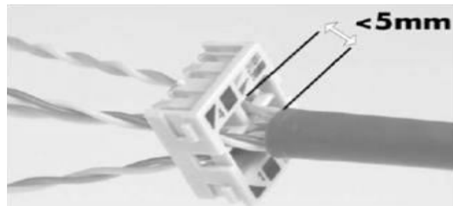
[그림 4-81] UTP Module 설치 (④ Organizer 간격 확보)
