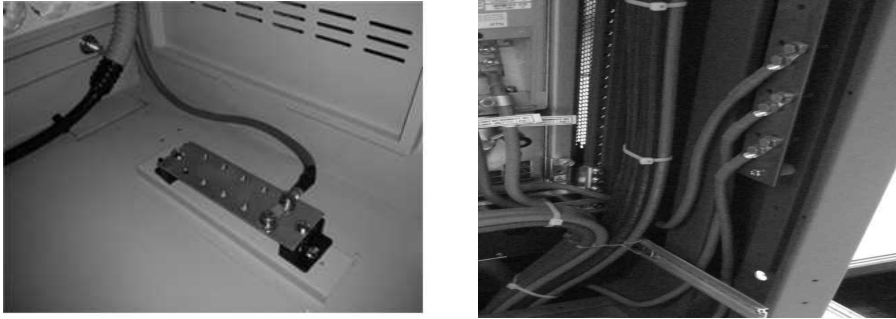
[그림 4-90] Rack 접지(예시)
