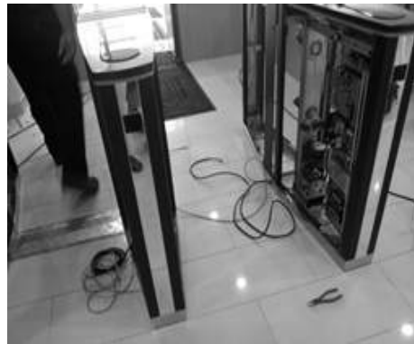
< 전원 및 통신선 연결 >
