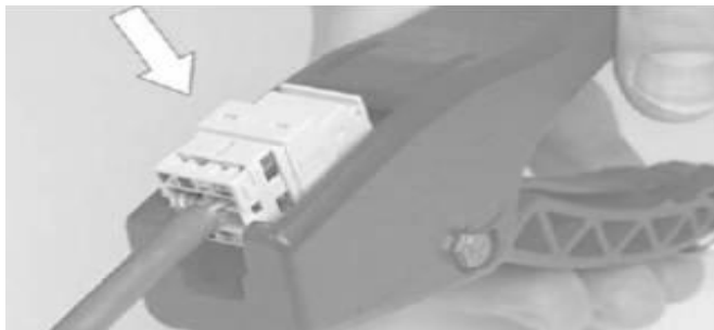
[그림 4-84] UTP Module 설치 (⑦ Tool에 커넥터 넣음)
