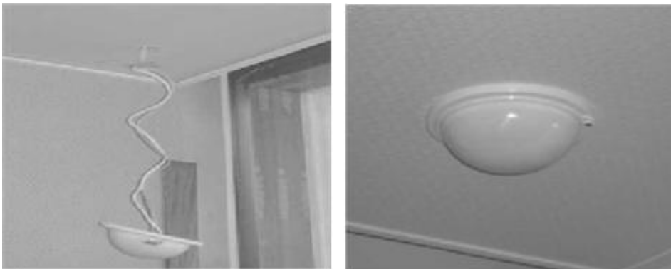
[그림 3-28] 동체 감지기 설치 사진<예시>
