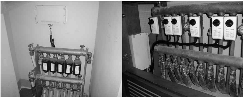
[그림 3-23] 온도조절 시스템 설치 예시
