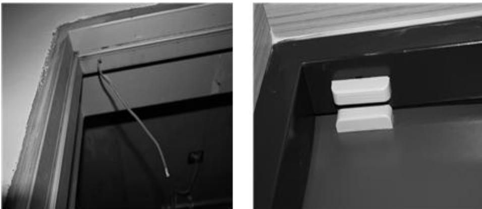
[그림 3-25] 자석감지기 설치 사진
