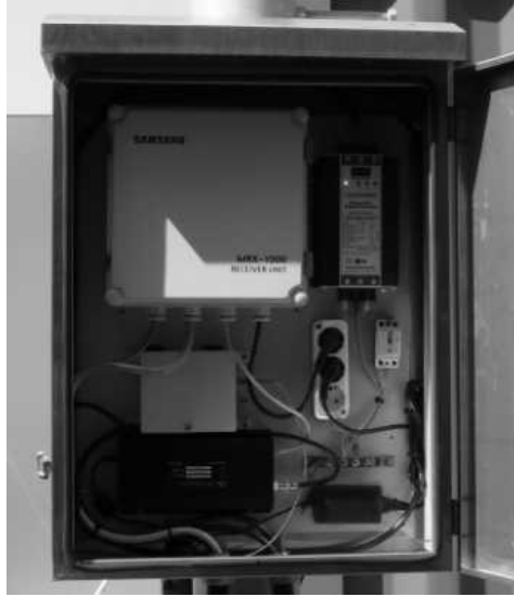
[그림 4-31] CCTV용 서지보호기 설치(사례)
