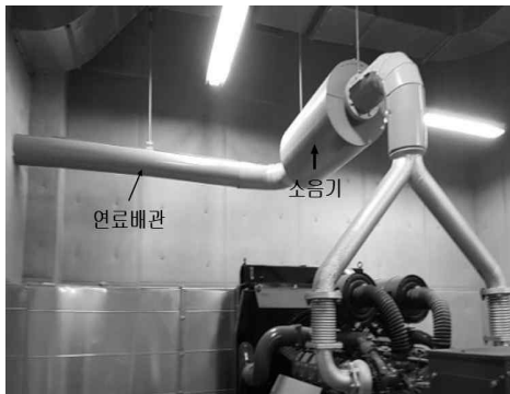
[그림 4-36] 비상발전기 연료용 배관 설치(예시)
