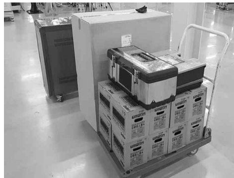
[그림 4-10] 무정전전원장치 설치장소 이동 및 포장 해제(예시)
