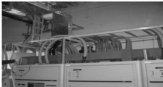
[그림 4-6] 정류기 입/출력 배선(예시)
