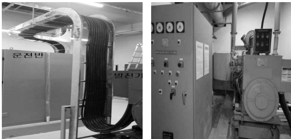
[그림 4-43] 운전반과 비상발전기 연결(예시)
