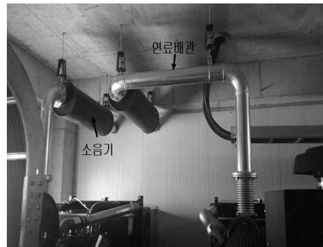
[그림 4-36] 비상발전기 연료용 배관 설치(예시)
