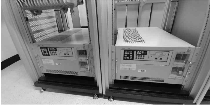
[그림 4-7] 정류기 DC/AC 변환장치(예시)
