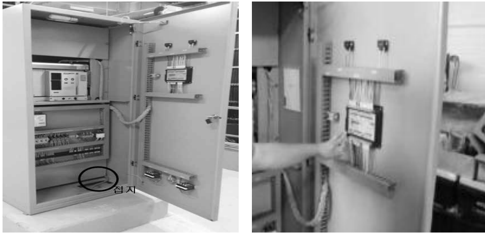
[그림 4-42] 운전반 연결 및 접지(예시)
