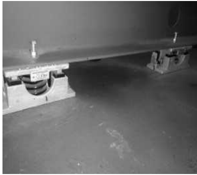
[그림 4-35] 비상 발전기 기초대(예시)
