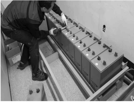
[그림 4-20] 음극, 양극 단자간 결선(예시)
