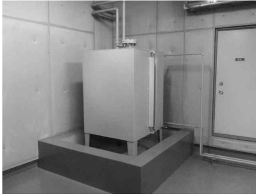
[그림 4-39] 비상발전기 연료탱크(예시)
