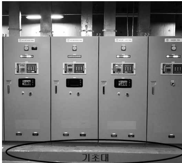
[그림 4-41] 운전반 기초대 설치(예시)
