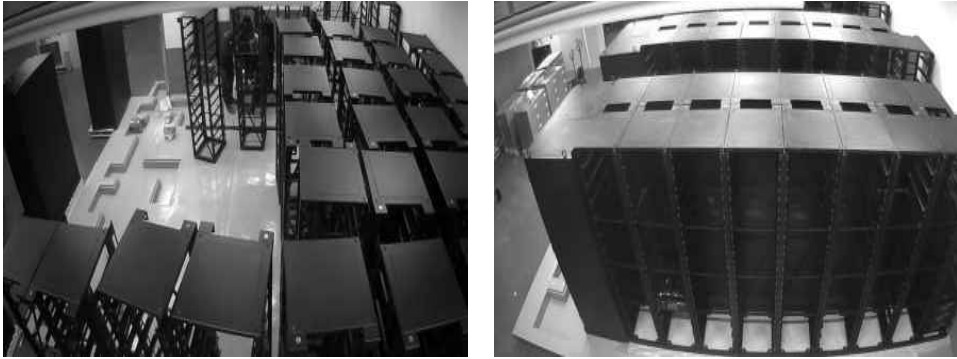
[그림 4-28] PCS 및 배터리 Rack설치(예시)
