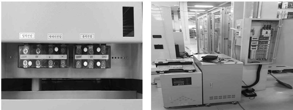
[그림 4-14] 무정전전원장치 배선연결(예시)
