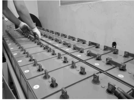
[그림 4-20] 음극, 양극 단자간 결선(예시)
