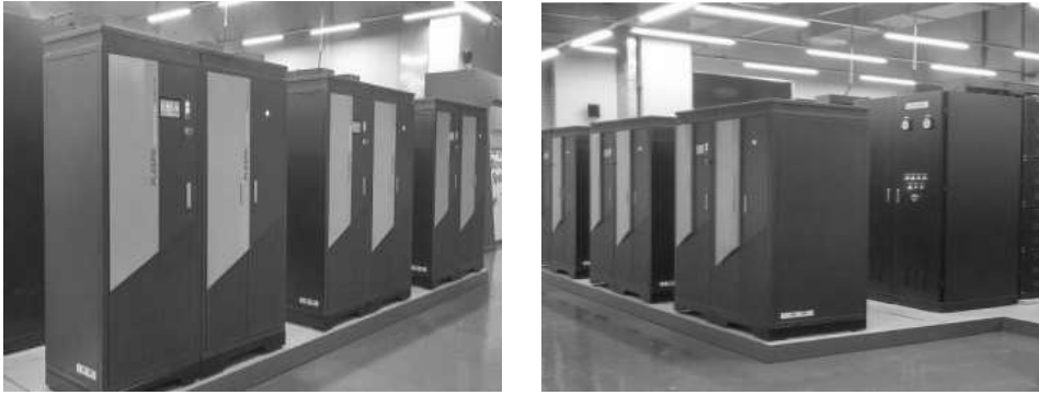
[그림 4-30] ESS 설치 완료(예시)
