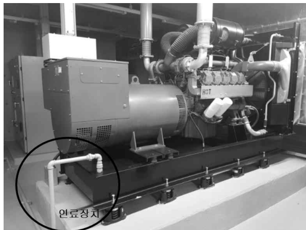
[그림 4-38] 비상발전기 연료배관(예시)
