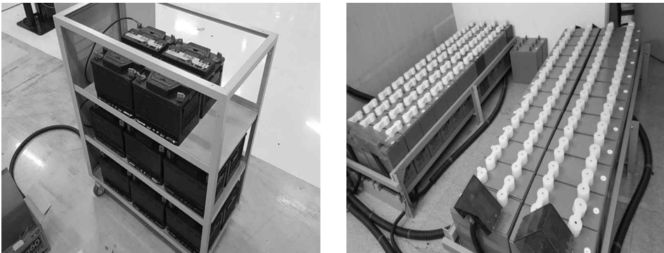
[그림 4-13] 축전지 설치(예시)
