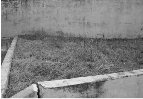
< 기초 터파기 전 >
