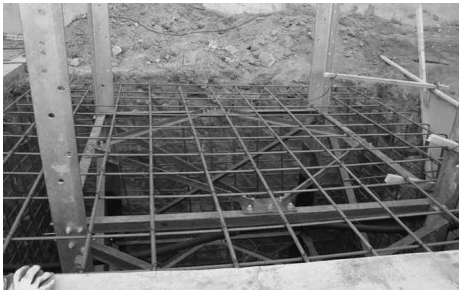
< 기초 이형철근 상부 >
