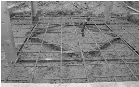
< 기초 콘크리트 타설 >
