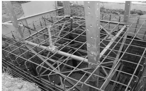
< 기초 피뢰접지 배관 및 철탐 접지 >
