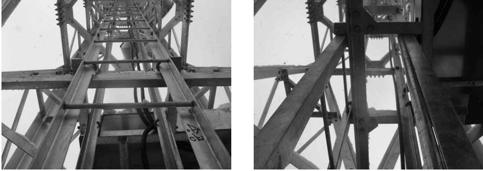
[그림 4-13] 사다리 설치
