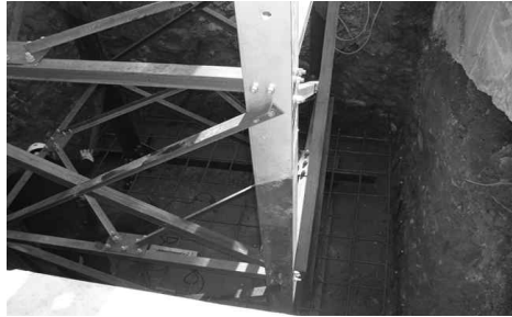
< 기초 바닥 이형철근 >
