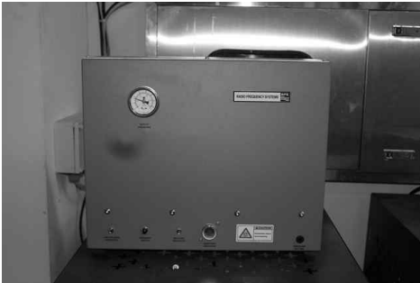
[그림 4-64] 공기주입기 설치
