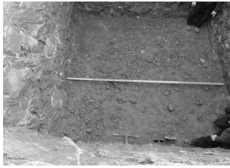
< 기초 터파기 바닥 右 >
