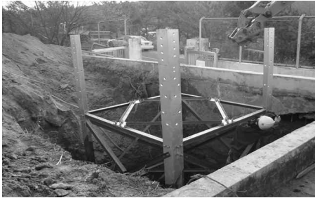
< 기초 철탐조립 전경 >
