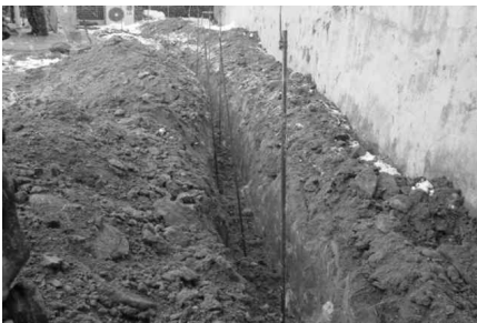
< 철탑 메인접지 터파기 및 접지동봉 >
