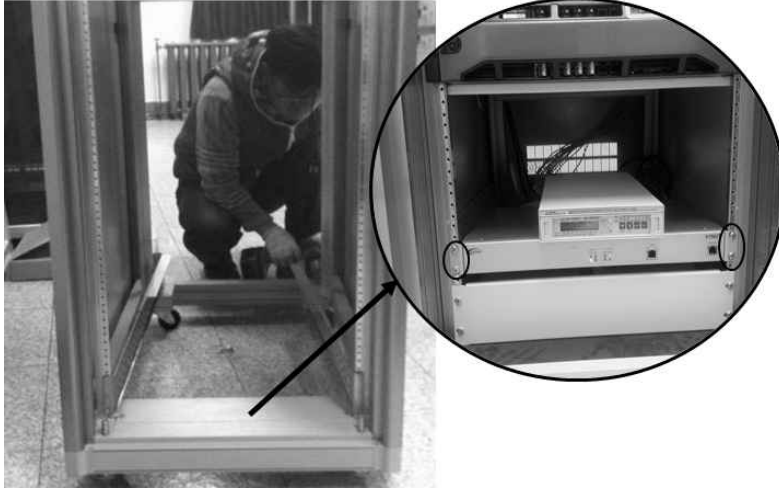
[그림 4-89] 주장치 설치
