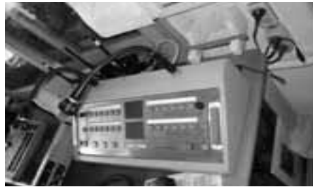
[그림 4-68] 조작반 설치
