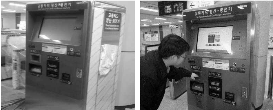
[그림 4-58] 자동정산기 설치 완료 및 동작 확인
