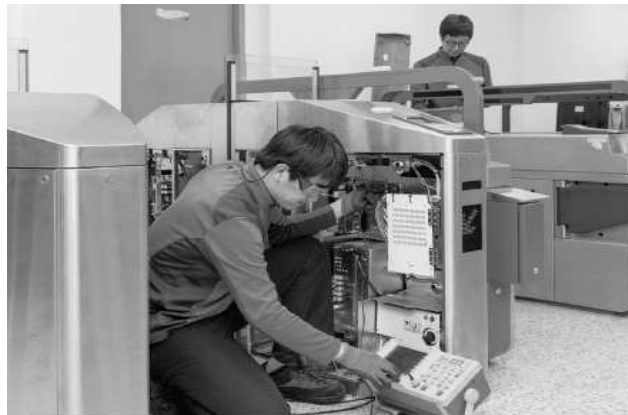
[그림 4-53] 자동개집표기 측정 및 점검
