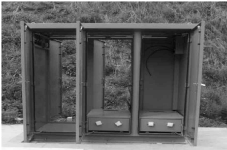
[그림 4-120] FM중계기함 중계장치 설치
