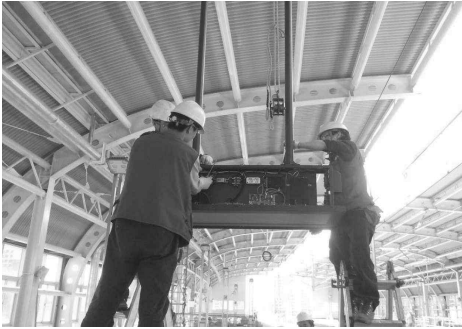
[그림 4-93] 행선안내게시기 설치
