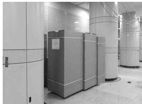
[그림 4-55] 자동정산기 이동 및 설치위치 확인
