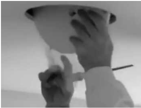
< ③ 설치면 및 스피커 선 정리 >
