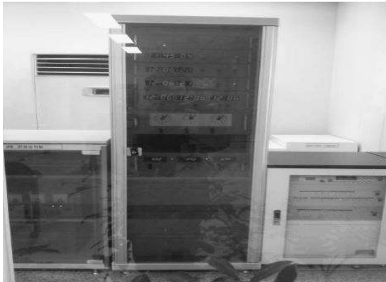
[그림 4-102] 부모시계 및 모시계 설치 완료
