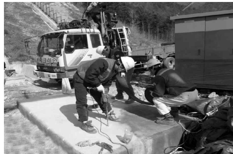
[그림 4-116] 기초대 앵커볼트 설치
