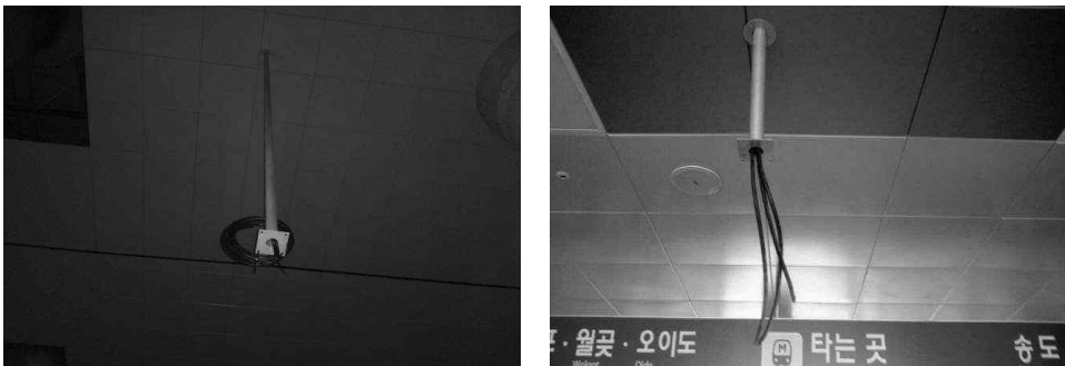
[그림 4-104] 자시계 브라켓 설치
