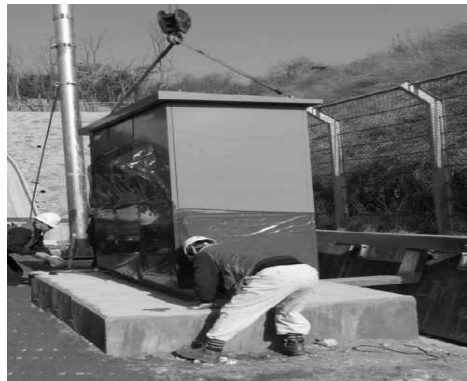
[그림 4-118] FM중계기함 설치
