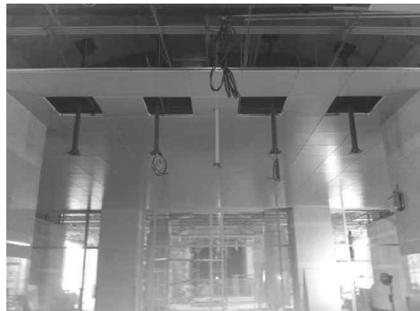
[그림 4-92] 행선안내게시기 브라켓 설치
