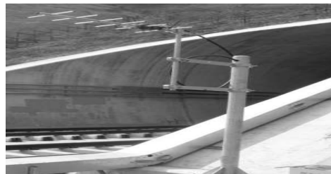
< 안테나 설치 완료 >
