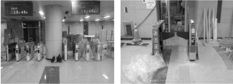
[그림 4-50] 자동개집표기 설치
