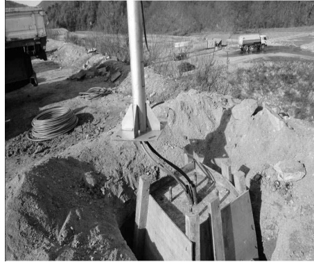
< 거푸집 및 기초대 설치 >
