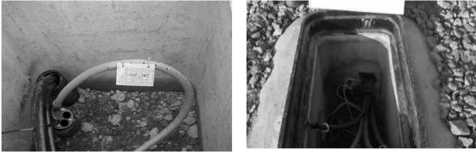
[그림 4-16] 내관 포설 설치 완료
