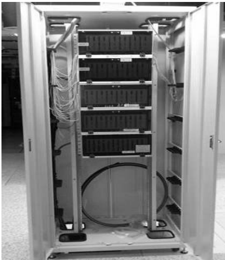
[그림 4-27] OFD 성단 완료<예시>
