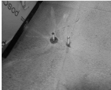
[그림 4-49] 앵커볼트 설치 및 자동개집표기설치
