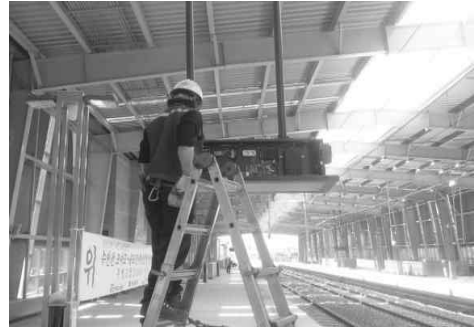
[그림 4-93] 행선안내게시기 설치
