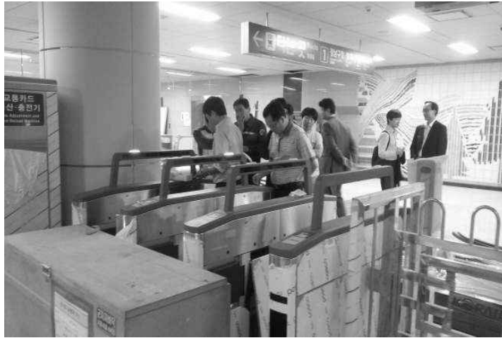
[그림 4-54] 자동개집표기 동작 확인 및 완료
