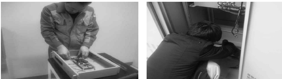
[그림 4-100] 부모시계 장비 설치
