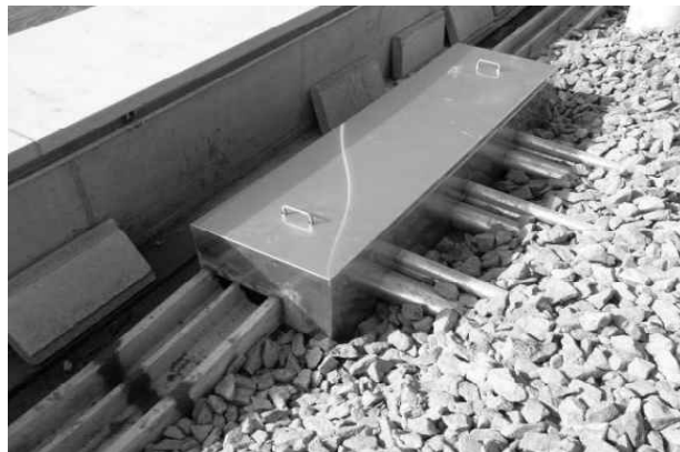
[그림 4-10] 선로변 통신선로 분배함 설치<예시>
