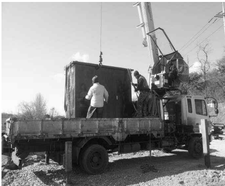
[그림 4-118] FM중계기함 설치
