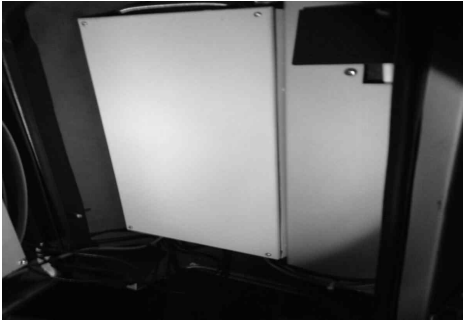
[그림 4-43] 연선전화기 단자함 방수판 부착 및 방수 처리
