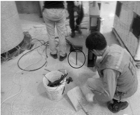
[그림 4-49] 앵커볼트 설치 및 자동개집표기설치
