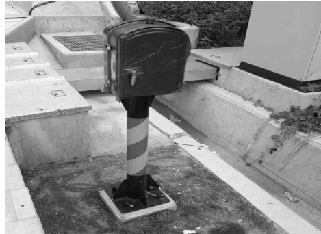
< 자립형 연선전화기 설치 완료 >
