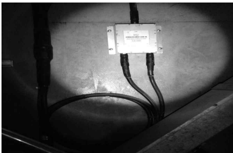
[그림 4-113] 분배기 설치
