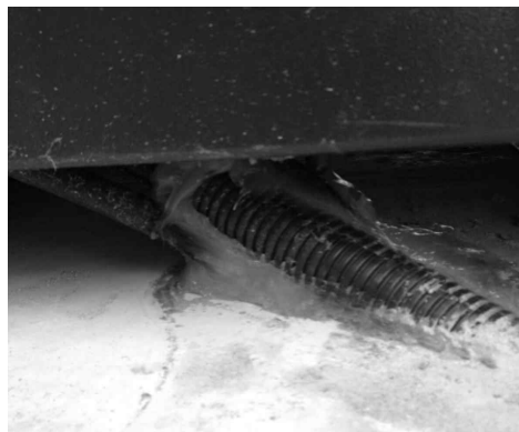
[그림 4-124] 케이블 배관 방수처리
