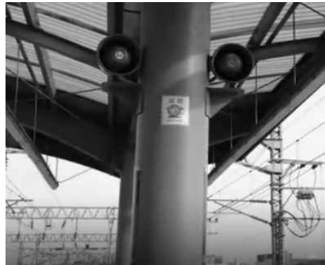
< ④ Horn Speaker 설치 완료 >
