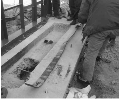
< 기초대 방진고무 설치 >
