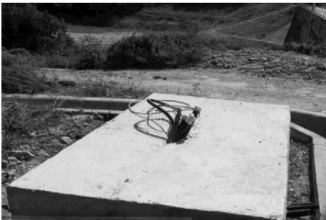
[그림 4-116] 기초대 앵커볼트 설치
