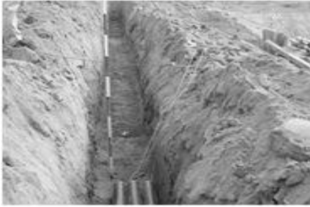
< 관로 터파기 작업 >
