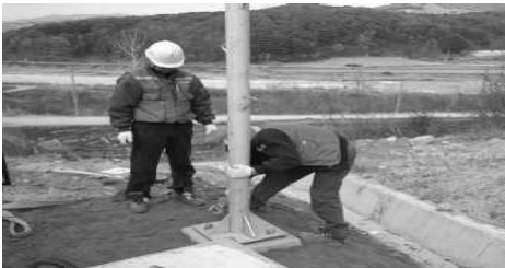
< 안테나 기초대 설치 >
