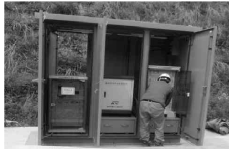
[그림 4-120] FM중계기함 중계장치 설치
