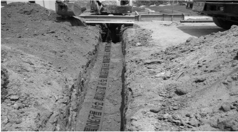
[그림 4-5] 경고테이프 설치
