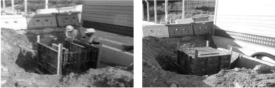
[그림 4-11] 거푸집으로 맨홀 설치<예시>
