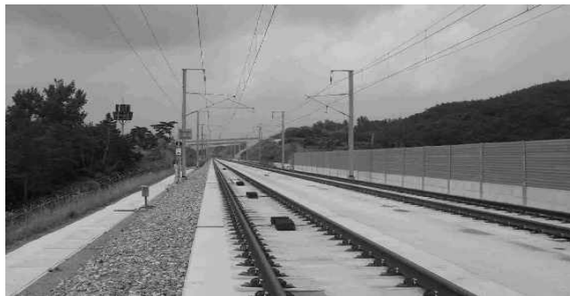
[그림 4-30] 열차자동제어장치 설치(예시)
