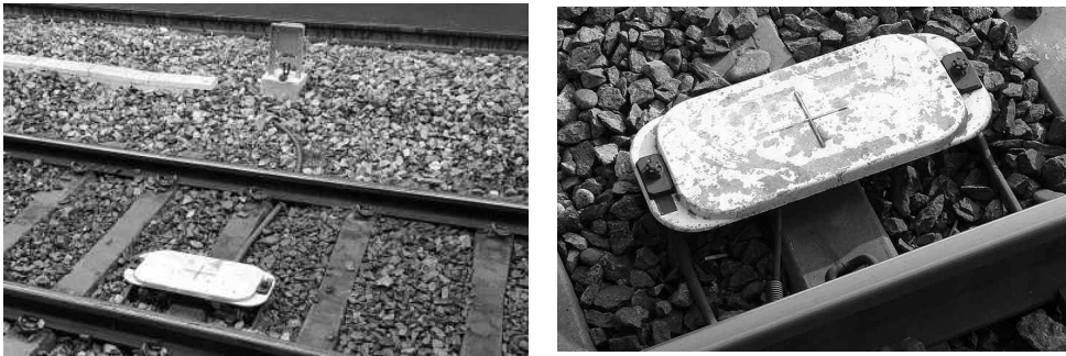
[그림 4-18] 지상자 설치
