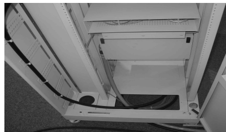
[그림 4-102] 인망제거 및 광케이블 성단을 위한 여장확보
