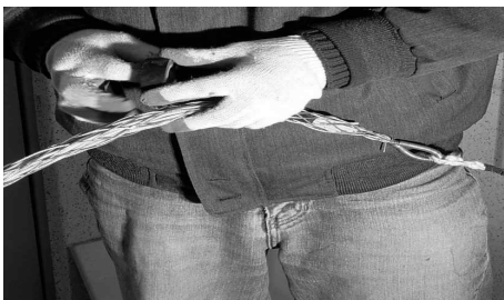
[그림 4-102] 인망제거 및 광케이블 성단을 위한 여장확보
