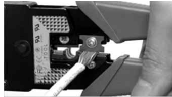
⑥ 공구(니퍼)를 사용하여 케이블 끝을 정리
