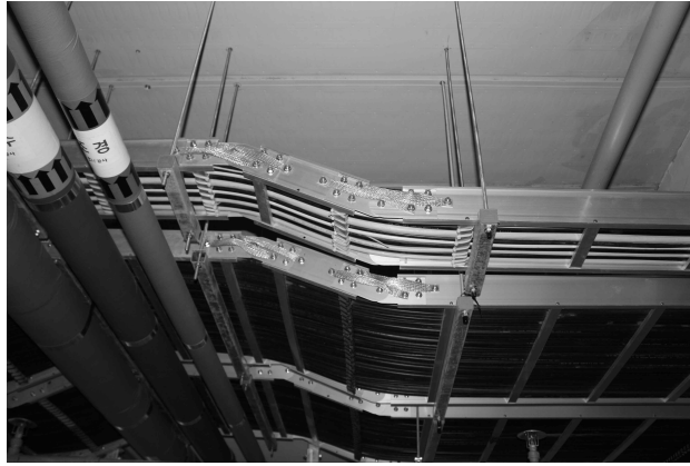
[그림 4-53] 교차구에서 케이블 트레이의 설치
