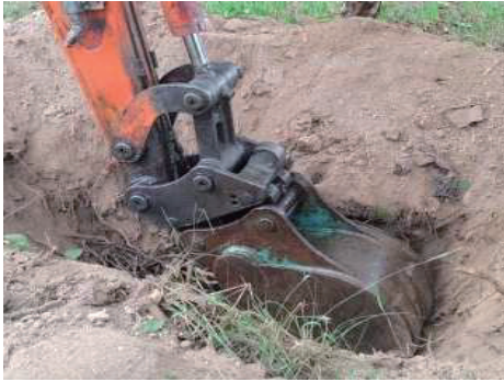
[그림 4-30] 터파기 및 되메우기(예시)
