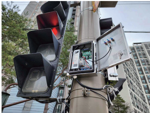
[그림 4-20] 제어함체 설치(예시)
