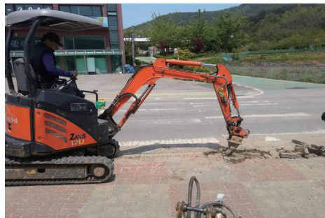
[그림 4-13] 점자블록 재단 및 절단(예시)
