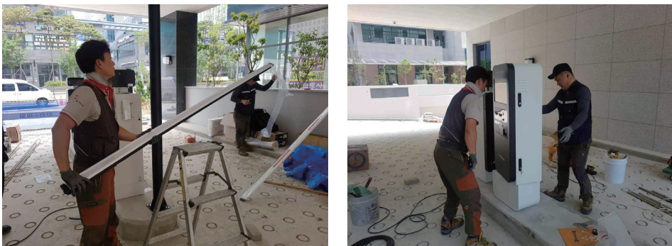
[그림 4-28] 차단기 및 요금정산기 설치(예시)
