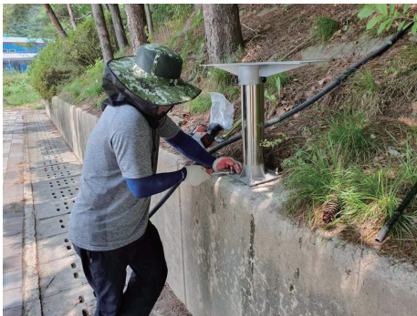
[그림 4-31] 지지대 설치 및 수평조정(예시)
