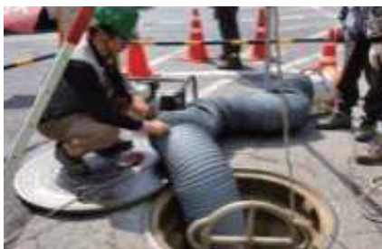
[그림 3-8] 산소 및 유해가스 농도 측정기 및 환기장치
