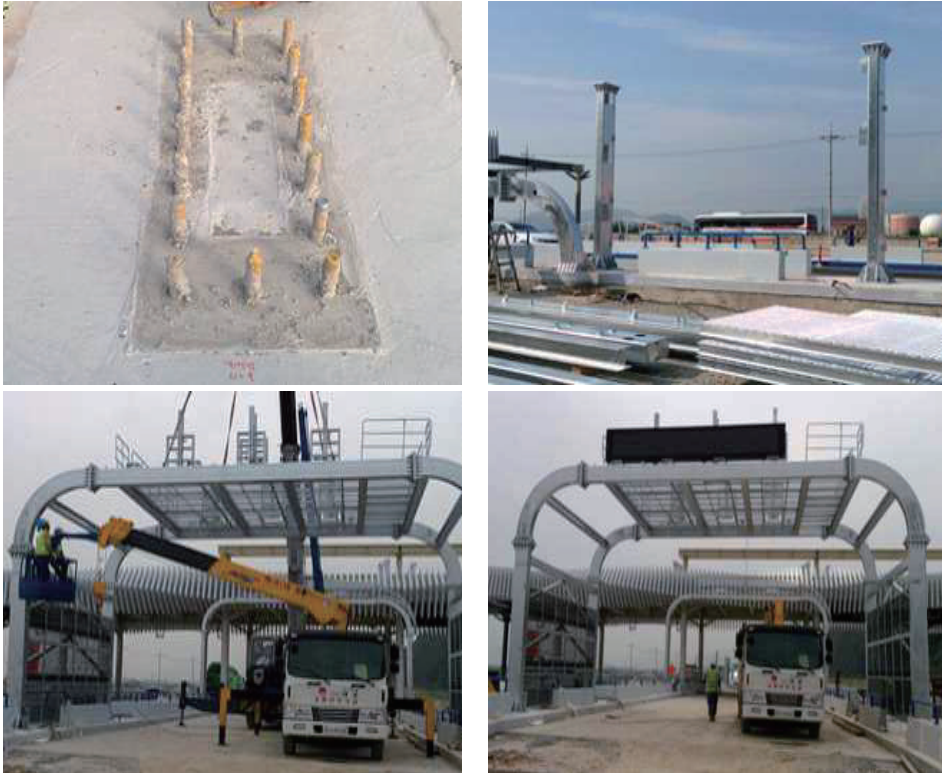
[그림 4-47] 갠트리 설치(예시)
