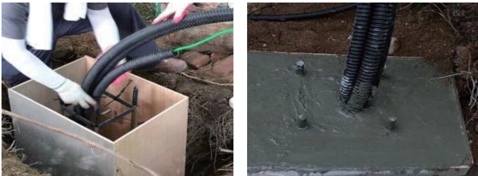
[그림 4-3] Pole 기초 설치(예시)
