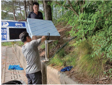
[그림 4-32] 안내판 취부 및 고정(예시)
