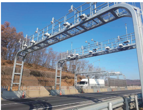
[그림 4-49] 영상촬영장치 설치(예시)
