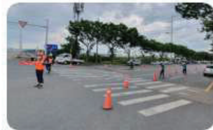
* 자료 : 한국산업안전보건공단, 정보통신공사 현장 안전작업 [그림 3-17] 신호수 배치(예시)
