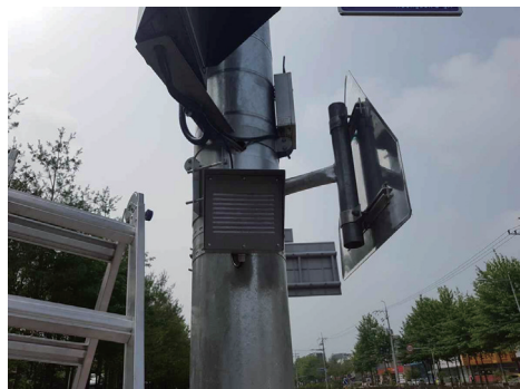
[그림 4-19] 스피커 설치(예시)
