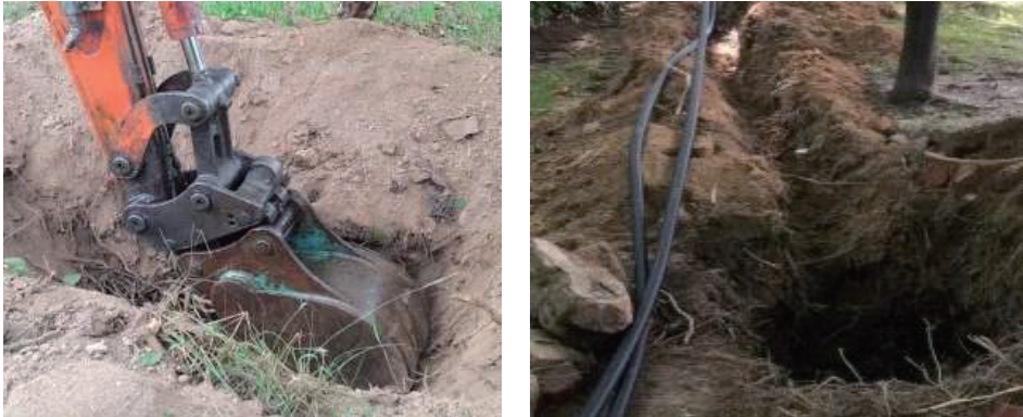
[그림 4-46] 터파기 및 되메우기(예시)
