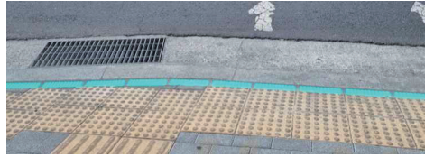
[그림 2-15] 바닥형 보행신호등 표출부 및 설치 사례(예시)
