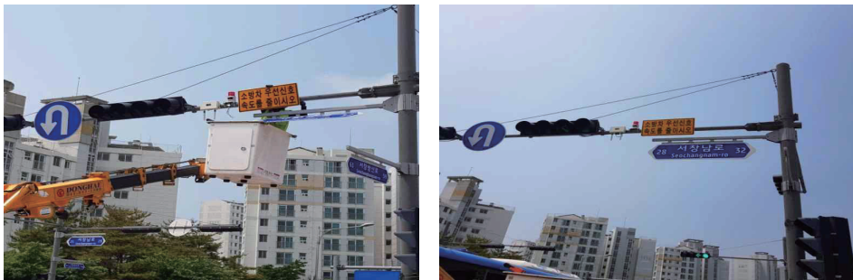
[그림 4-6] 경광등 및 표지판 설치(예시)
