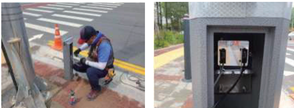
[그림 4-21] 센서 Pole 설치(예시)
