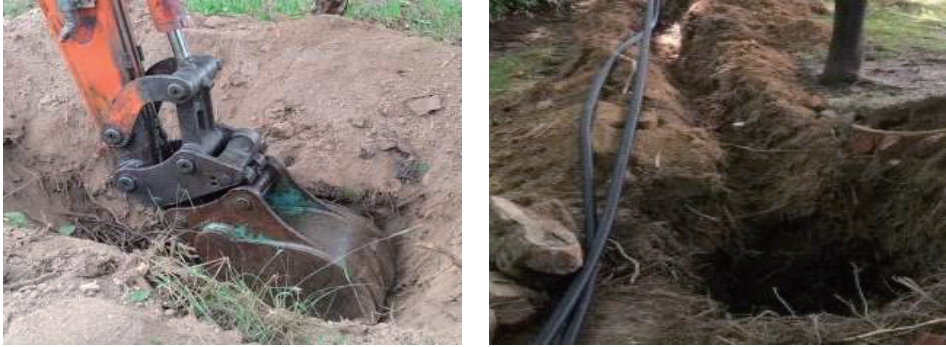
[그림 4-2] 터파기 및 되메우기(예시)
