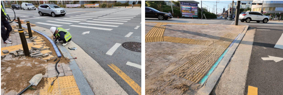
[그림 4-14] LED 모듈 설치(예시)
