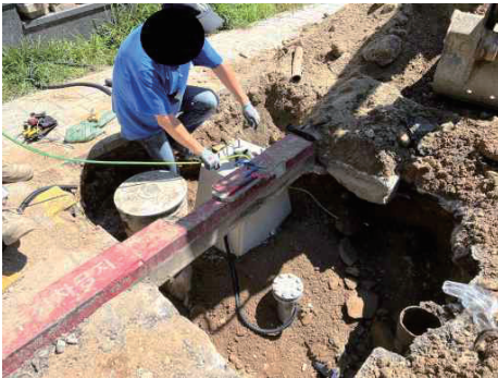
[그림 4-41] Pole 기초 설치(예시)
