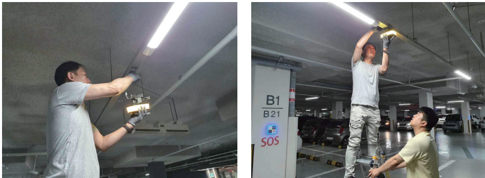
[그림 4-35] 카메라 취부(예시)
