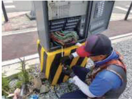
[그림 4-22] 케이블 결선(예시)
