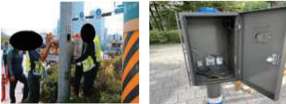
[그림 4-44] 제어함체 설치(예시)
