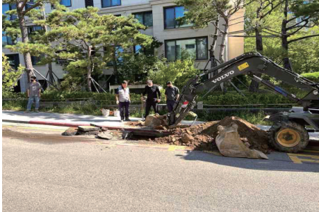
[그림 4-12] 터파기 및 되메우기(예시)
