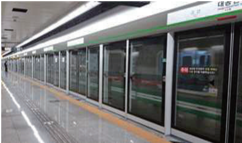
[그림 2-27] 승강장 안전문 설비(예시)
