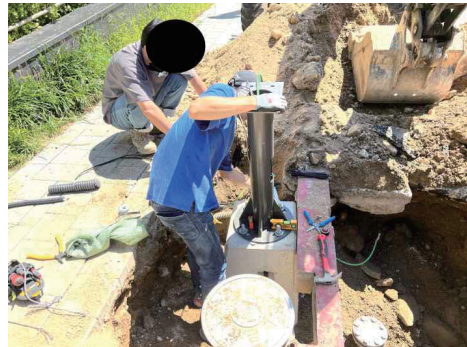
[그림 4-41] Pole 기초 설치(예시)
