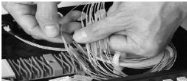
[그림 4-54] FDF 설치 (⑧ 케이블 정리)
