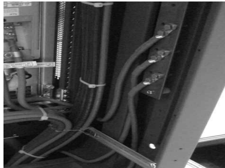
[그림 4-10] Rack 접지(예시)
