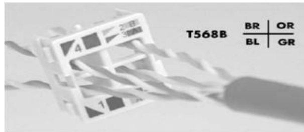
[그림 4-17] UTP Module 설치 (③ 페어별로 끼움)
