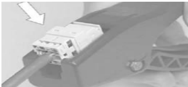
[그림 4-21] UTP Module 설치 (⑦ Tool에 커넥터 넣음)
