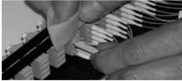
[그림 4-52] FDF 설치 (⑥ 어댑터 연결)
