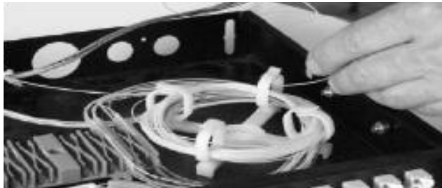
[그림 4-50] FDF 설치 (④ 고정고리에 고정)
