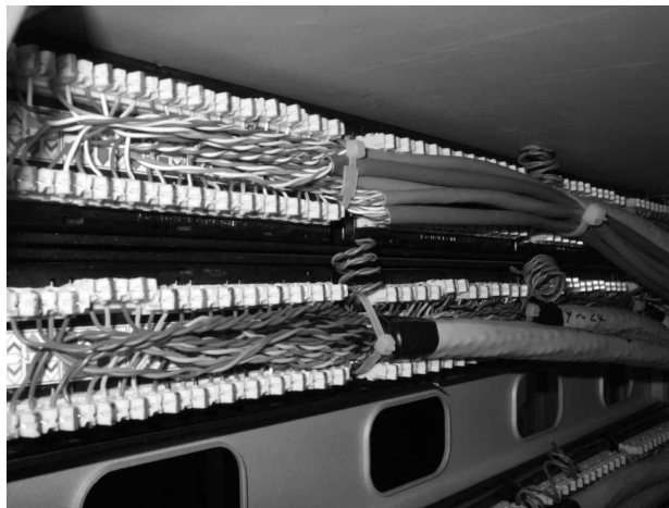
[그림 4-60] 패치판넬 설치 (⑤ 케이블 고정)
