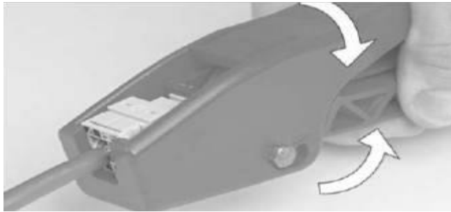
[그림 4-22] UTP Module 설치 (⑧ Tool로 고정)
