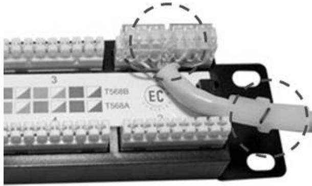
[그림 4-59] 패치판넬 설치 (④ 케이블 마킹)
