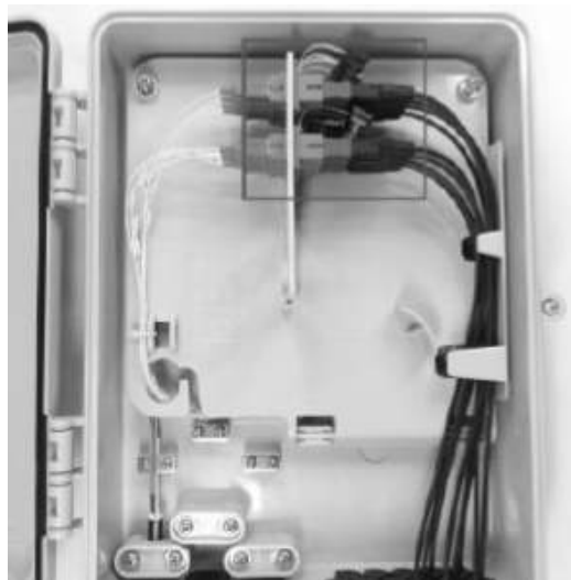
[그림 4-79] 광단자함 설치 (⑦ 광옥외선 연결)
