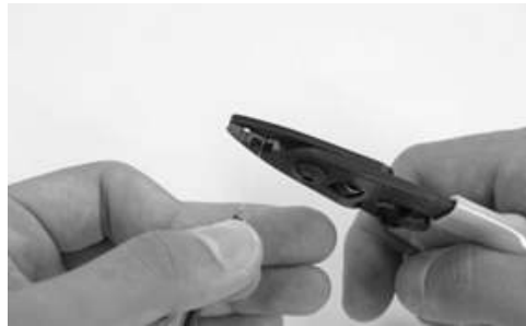
[그림 4-45] 현장커넥터 접속(③ 코팅(250 \mu m) 탈피)
