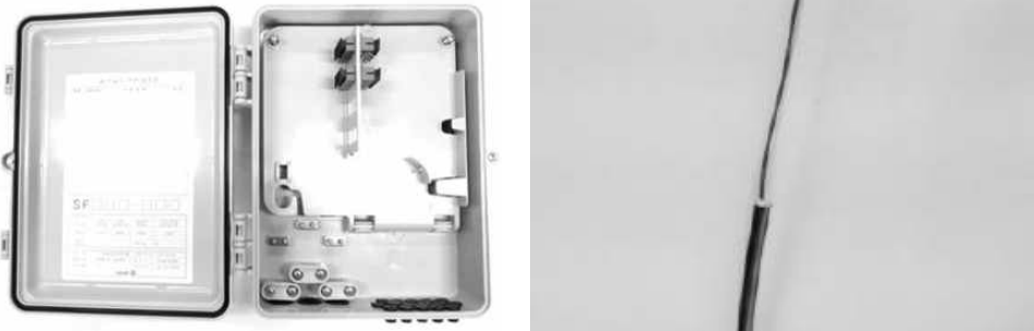
[그림 4-73] 광단자함 설치 (① 광단자함 및 광케이블 준비)
