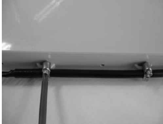
[그림 4-66] 광분배함 설치 (② 케이블을 스틸밴드로 고정)
