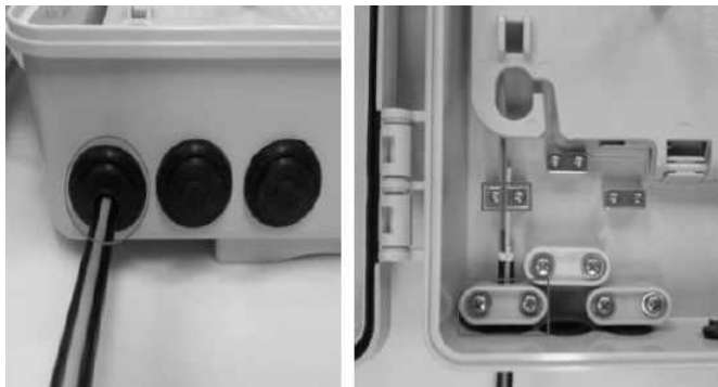
[그림 4-74] 광단자함 설치 (② 인입 광케이블 고정)
