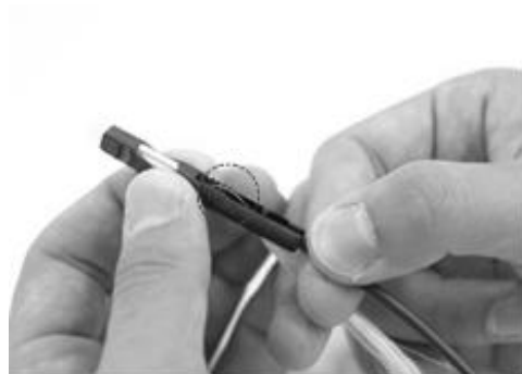
[그림 4-48] 현장커넥터 접속(⑥ 광섬유 벤딩 확인)
