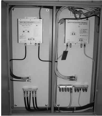
[그림 4-147] 동,총단자함 증폭기 및 분배기 설치
