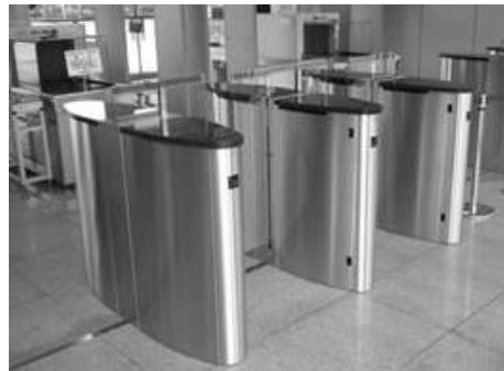
< Speed Gate 시공 완료 >
