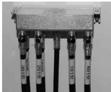
[그림 4-148] 케이블 라벨링 및 커넥터 연결
