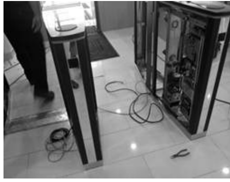
< 전원 및 통신선 연결 >
