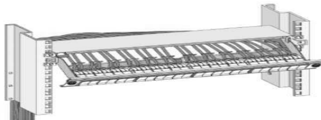
[그림 4-87] UTP 패치패널 설치(Ⅲ) 케이블 성단
