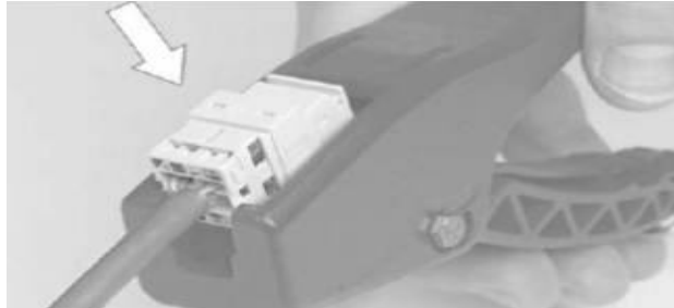
[그림 4-97] UTP Module 설치(VII) Tool에 커넥터 넣음
