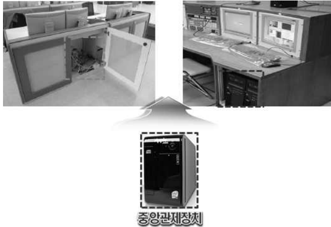
[그림 4-26] 중앙관제장치 설치
