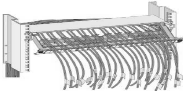
[그림 4-86] UTP 패치패널 설치(Ⅱ) 케이블 배열
