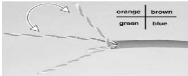
[그림 4-92] UTP Module 설치(Ⅱ) 페어별 구분
