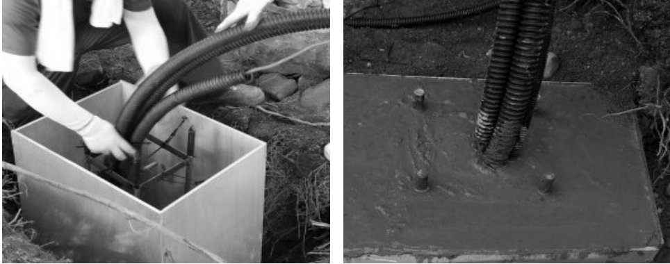
[그림 4-38] Pole 기초 설치(예시)
