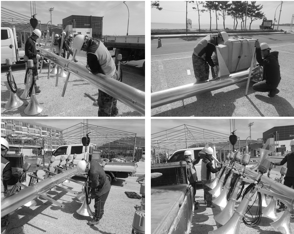
[그림 4-29] 브라켓 및 스피커 설치(예시)
