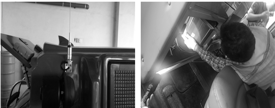
[그림 4-72] 안테나 및 무선중계장치 설치[이동형](예시)
