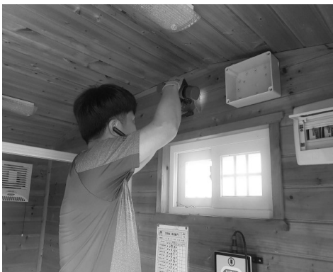
[그림 4-10] 감지기 설치(예시)
