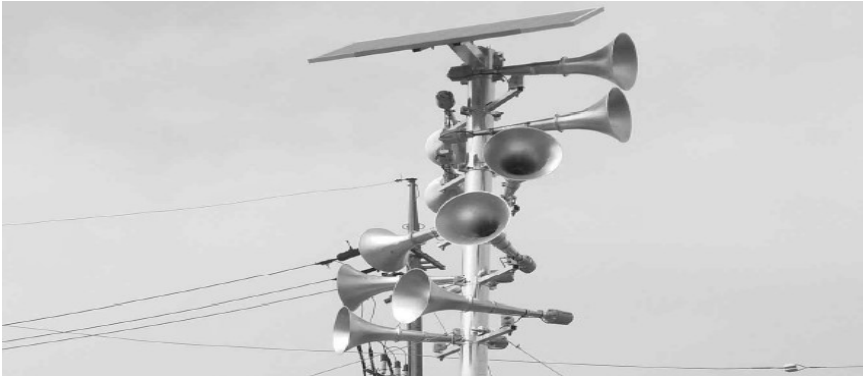
[그림 2-24] 재난 예·경보시스템 스피커(예시)
