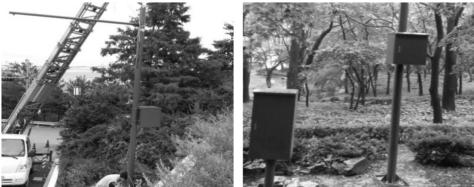
[그림 4-39] Pole 설치(예시)
