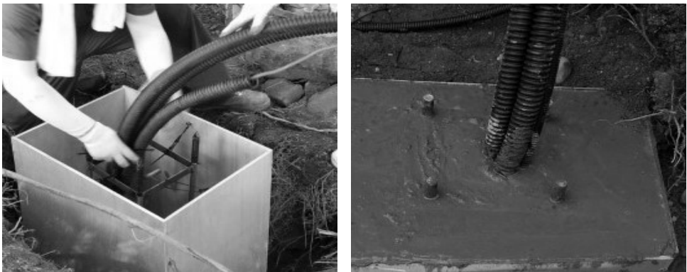
[그림 4-45] Pole 기초 설치(예시)
