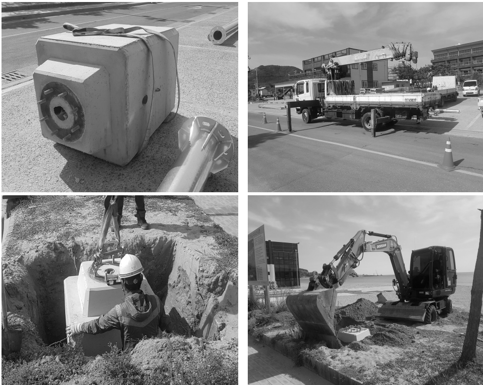
[그림 4-28] 기초대 설치(예시)
