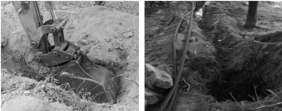
[그림 4-37] 터파기 및 되메우기(예시)
