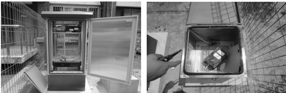
[그림 4-22] 지진가속도 기록계 및 감지기 함체 설치(예시)
