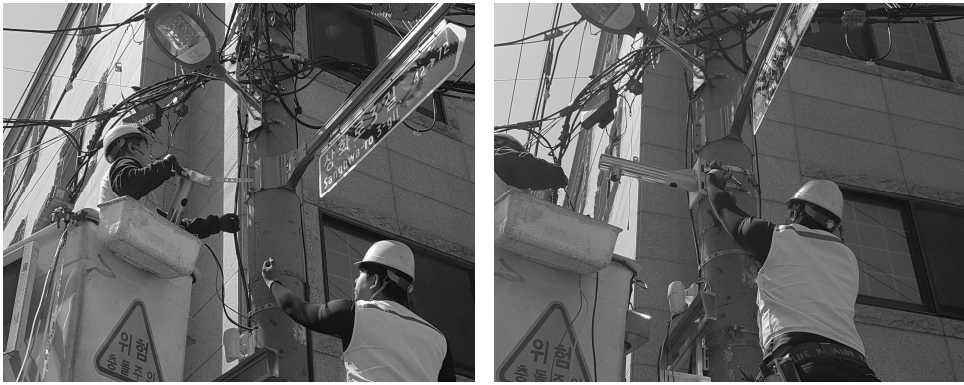
[그림 4-40] 브라켓 설치(예시)
