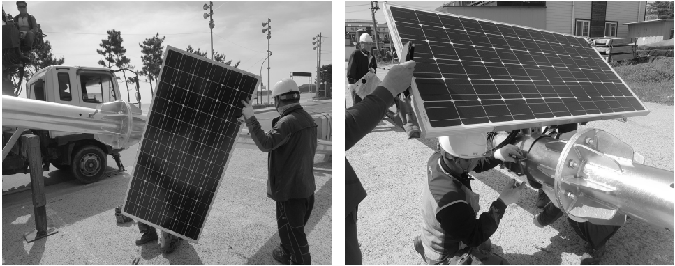
[그림 4-30] 태양전지판 설치(예시)
