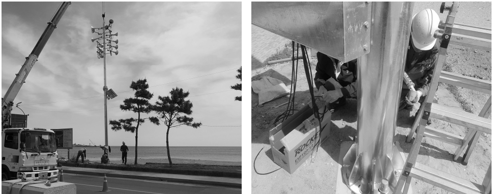
[그림 4-31] Pole 설치(예시)
