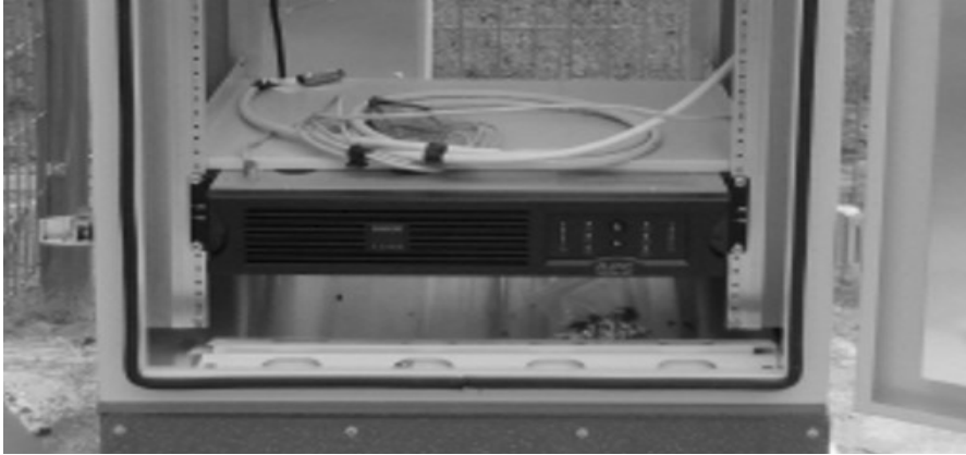
[그림 4-25] 전원공급장치 설치(예시)
