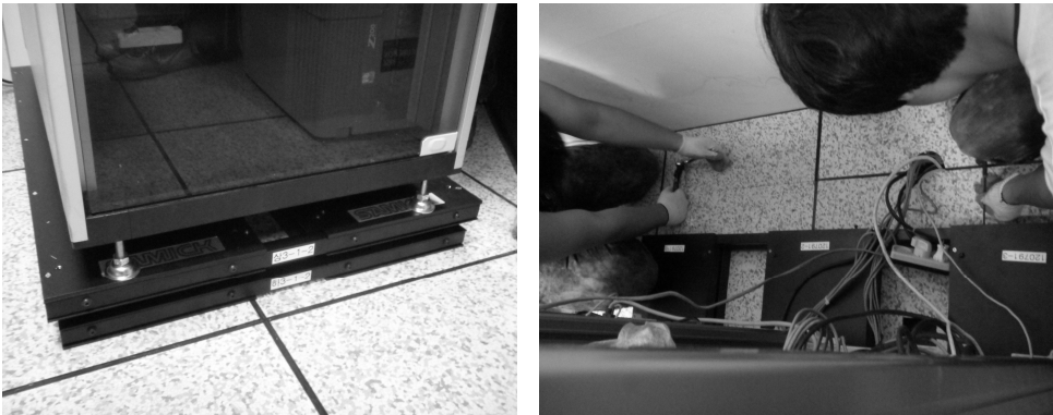
[그림 4-64] 랙 고정 및 케이블 정리(예시)
