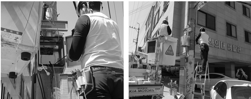
[그림 4-41] 외함 설치(예시)
