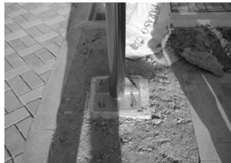
[그림 4-17] 기초대 및 폴(Pole)설치(예시)
