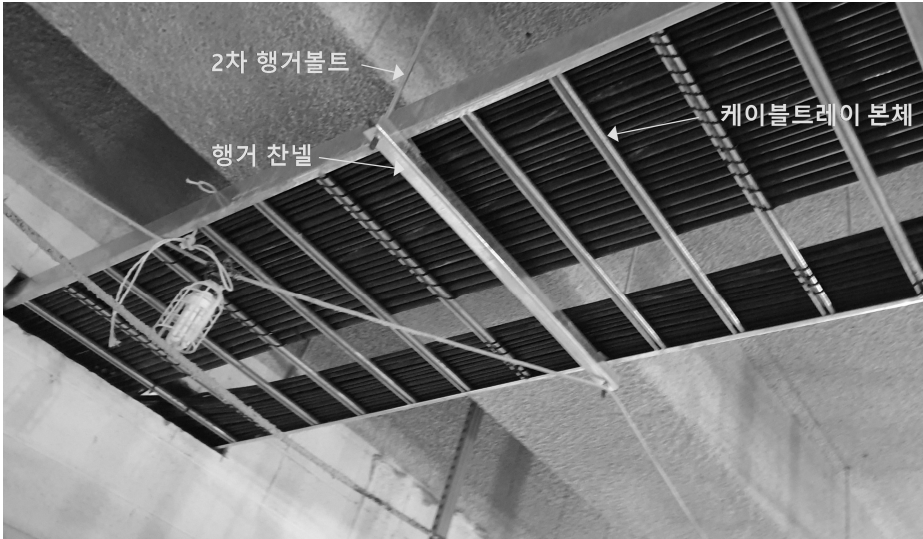
[그림 4-67] 행거 채널 및 케이블 트레이 본체 설치(예시)
