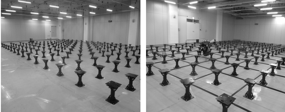
[그림 4-57] 포스트 및 연결대 설치(예시)
