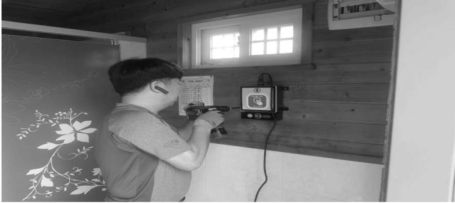
[그림 4-9] 비상벨 설치(예시)
