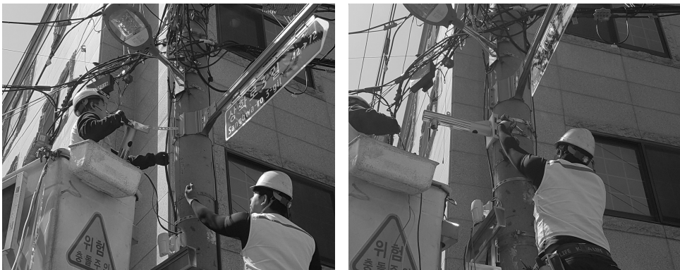
[그림 4-47] 브라켓 설치(예시)
