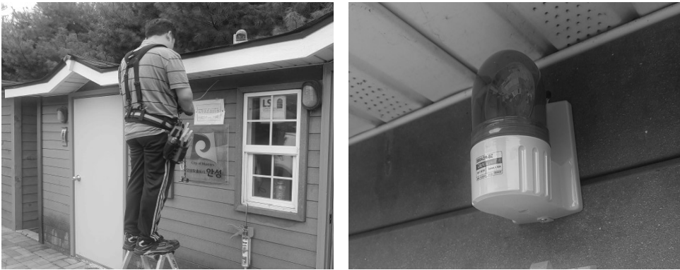
[그림 4-11] 경광등 설치(예시)
