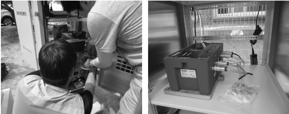
[그림 4-23] 지진가속도 기록계 설치(예시)
