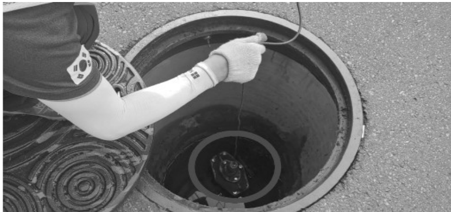
[그림 4-5] 센서부 취부(예시)
