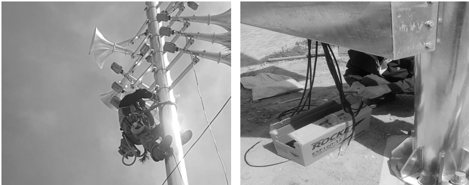
[그림 4-34] 케이블 연결 및 조정(예시)
