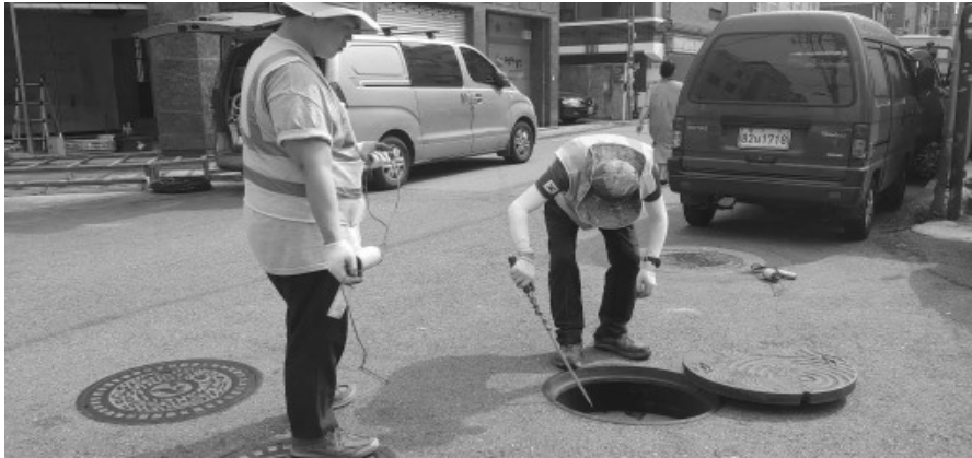
[그림 4-3] 상수도 맨홀 뚜껑 열기(예시)
