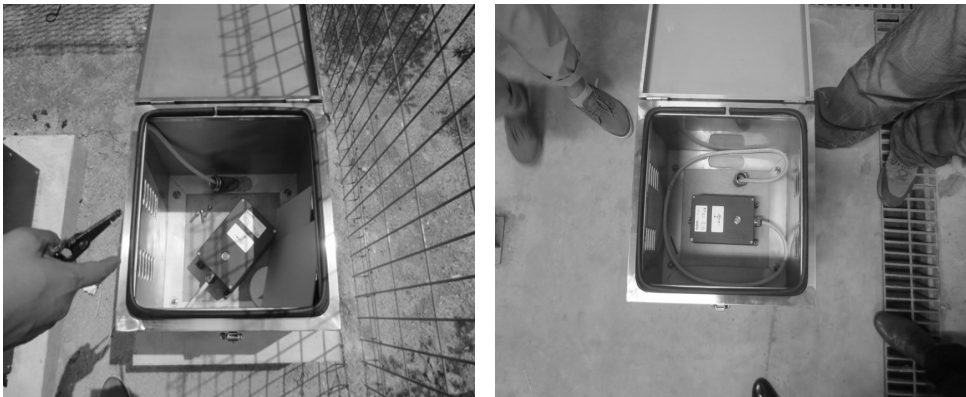
[그림 4-24] 지진가속도 기록계 설치(예시)
