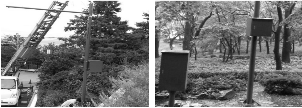
[그림 4-46] Pole 설치(예시)
