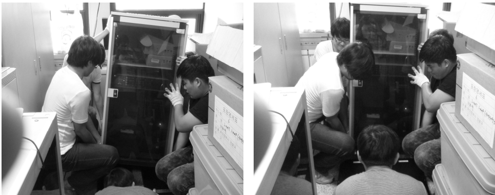
[그림 4-62] 면진테이블 설치(예시)
