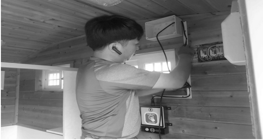
[그림 4-12] 배관 및 배선 시공(예시)
