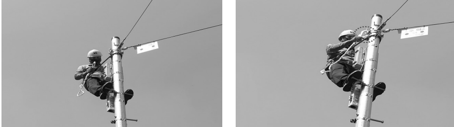
[그림 3-20] 안전대 착용 및 고정(예시)
