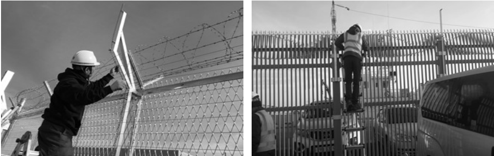
[그림 4-50] 신호분석장치 설치(예시)
