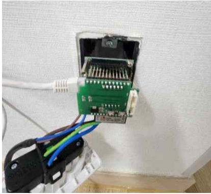
[그림 4-34] 층간소음 측정 단말기 설치(예시)
