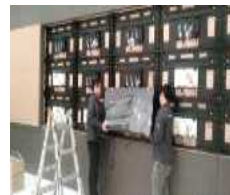
[그림 4-11] 디스플레이 패널 설치(예시)
