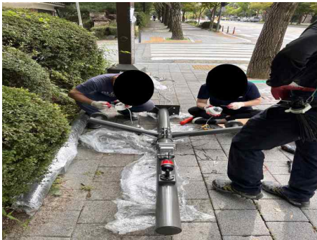
[그림 4-19] Pole 설치(예시)
