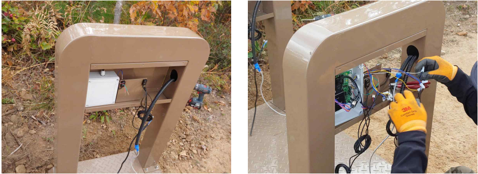
[그림 4-21] 센서 및 제어함체 설치(예시)
