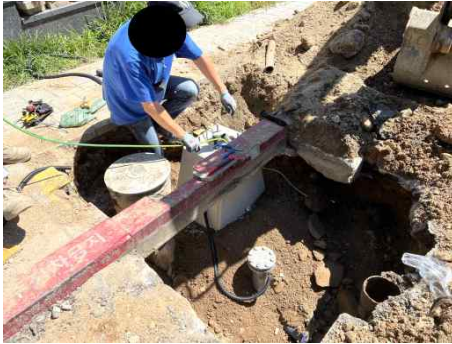
[그림 4-18] Pole 기초 설치(예시)
