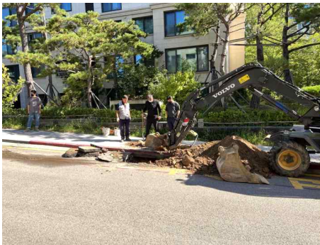
[그림 4-17] 터파기 및 되메우기(예시)
