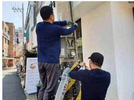
[그림 4-28] 브라켓 및 외함 설치(예시)
