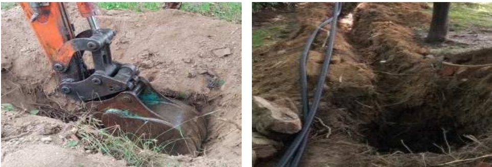
[그림 4-25] 터파기 및 되메우기(예시)
