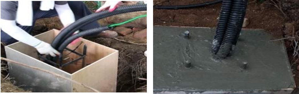
[그림 4-26] Pole 기초 설치(예시)
