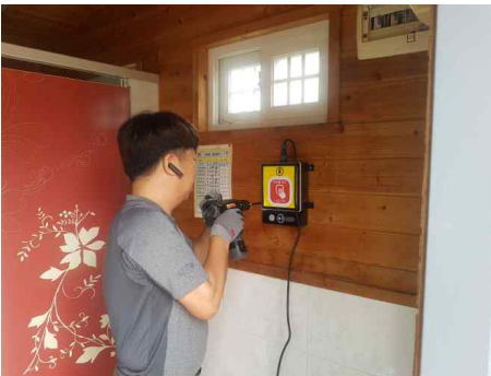
[그림 4-32] 건설 현장 비상벨 설비 설치(예시)
