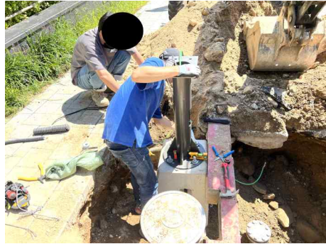
[그림 4-18] Pole 기초 설치(예시)
