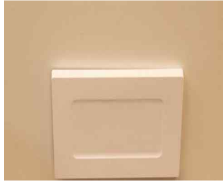
[그림 4-34] 층간소음 측정 단말기 설치(예시)
