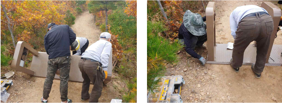
[그림 4-20] 게이트 조립 및 고정(예시)
