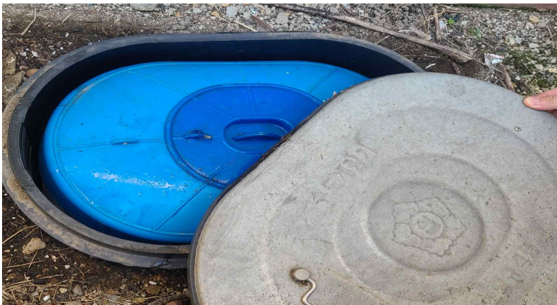
[그림 4-41] 상수도 계량기보호통(뚜껑) 열기(예시)
