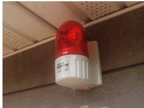
[그림 4-32] 건설 현장 비상벨 설비 설치(예시)
