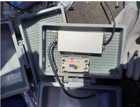
[그림 4-28] 브라켓 및 외함 설치(예시)
