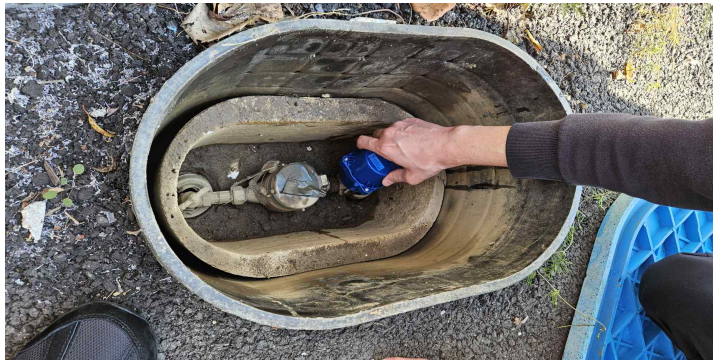
[그림 4-42] 누수 원격 관리 센서부 취부(예시)
