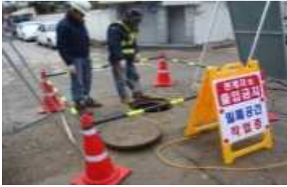
[그림 3-9] 안전 표지판 및 출입금지 조치(예시)
