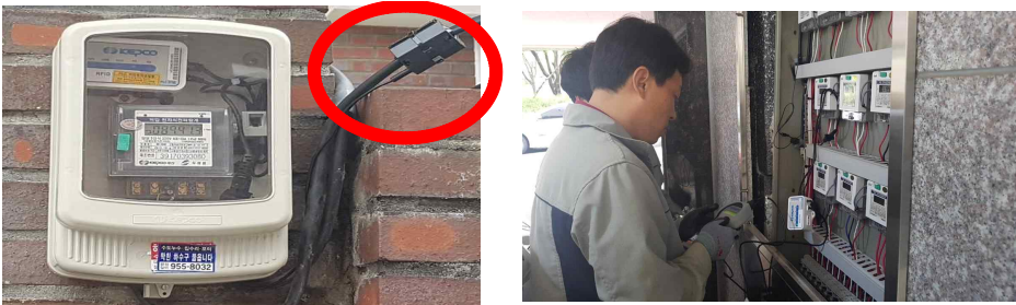
[그림 3-28] 커플러 설치(예시)
