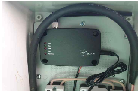
[그림 3-24] RTU 설치(예시)
