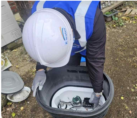
[그림 3-10] 데이터수집장치 설치(예시)
