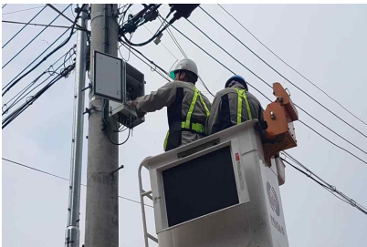
[그림 3-27] 데이터집중장치(DCU) 설치(예시)
