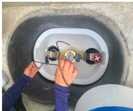
[그림 3-9] 원격검침기 설치(예시)
