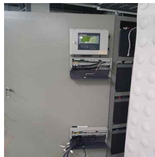
[그림 3-36] 배터리 제어장치 설치(예시)
