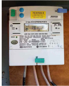
[그림 3-31] 전력량 계출장치 설치(예시)
