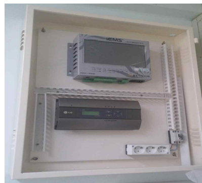
[그림 3-32] 최대전력관리장치 설치(예시)
