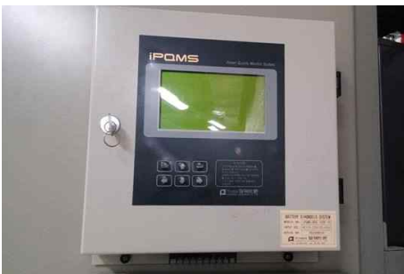
[그림 3-36] 배터리 제어장치 설치(예시)
