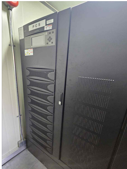
[그림 3-40] 전력변환장치(PCS) 설치(예시)
