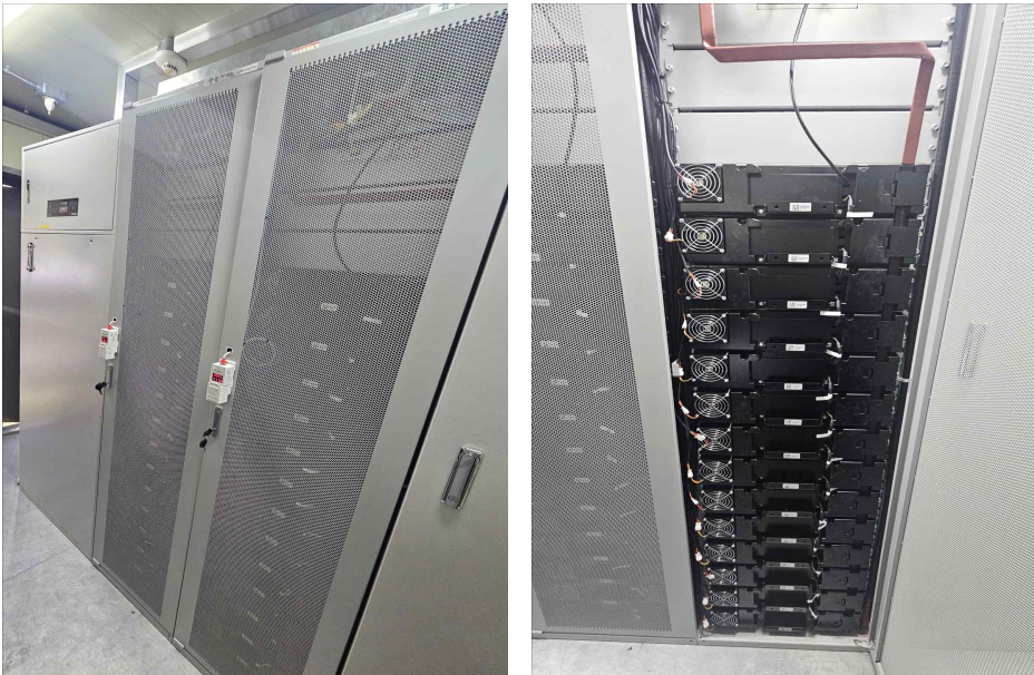
[그림 3-39] 에너지저장장치 설치(예시)
