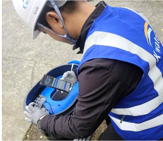
[그림 3-11] 통신 설정 및 상태 확인(예시)
