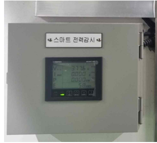
[그림 3-23] 단자함 설치(예시)
