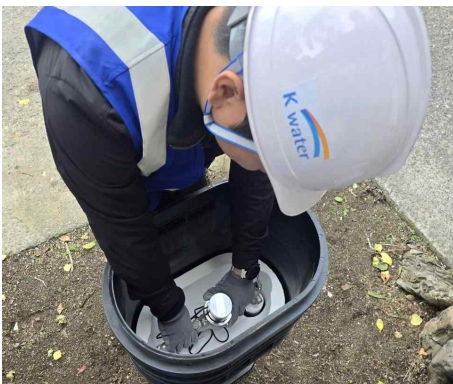
[그림 3-9] 원격검침기 설치(예시)
