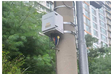
[그림 3-27] 데이터집중장치(DCU) 설치(예시)
