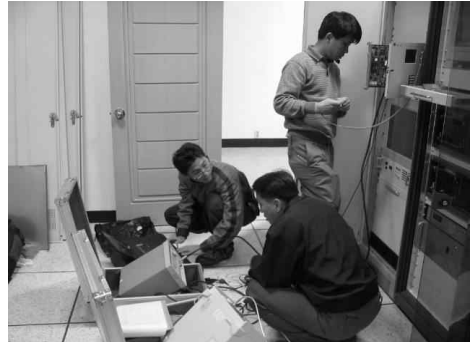
[그림 4-34] 장비 전원인가 확인 및 장비 검사
