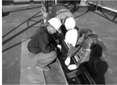
[그림 4-57] 옥외케이블 설치
