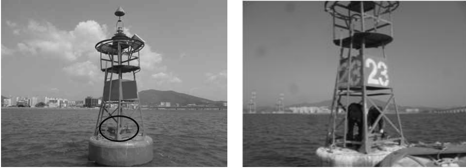
[그림 4-24] 등대에 축전지 설치 위치
