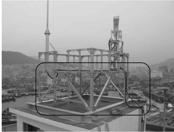
[그림 4-7] 해상 및 해안 레이더(안테나) 케이블 고정(예시)
