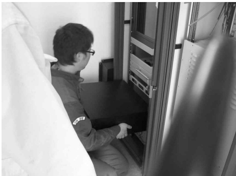
[그림 4-16] 레이더 추적장치 랙 실장(예시)
