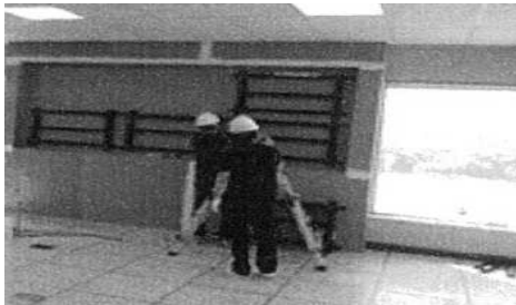
< 모니터 브라켓 설치 >
