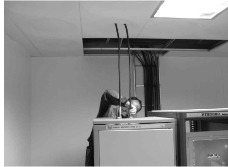
[그림 4-61] VHF대역 방향탐지기 피더케이블 장비 수용고정
