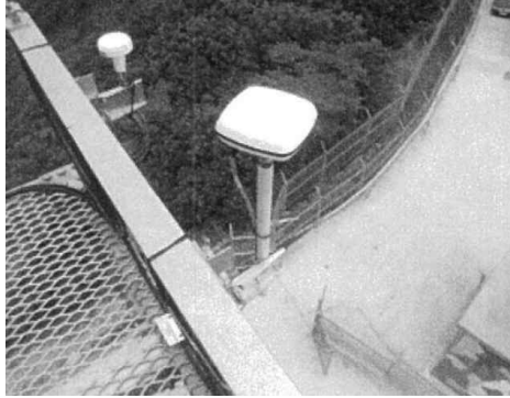
[그림 4-69] GPS안테나 및 DGPS안테나 설치
