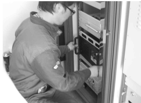
[그림 4-16] 레이더 추적장치 랙 실장(예시)
