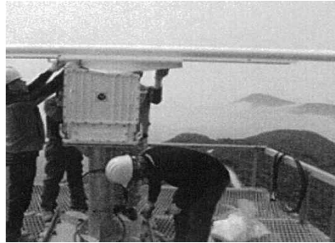
[그림 4-3] 해안 및 해상레이더(안테나)설치
