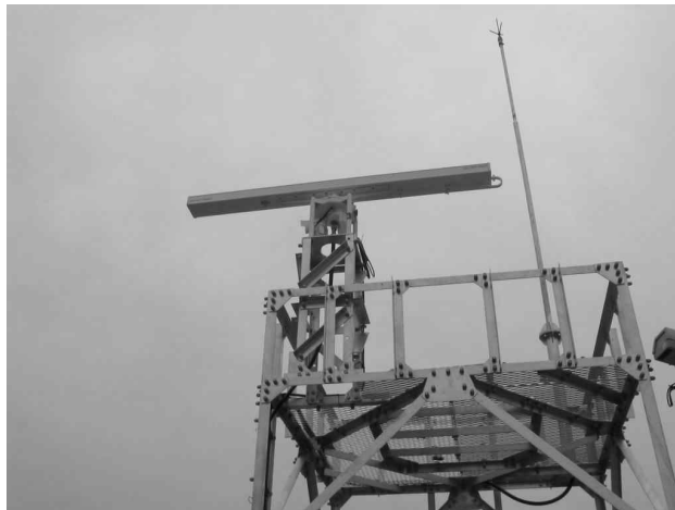
[그림 4-8] 해상 및 해안 레이더(안테나) 시공 완료
