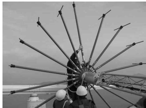
[그림 4-60] VHF대역 방향탐지기 안테나 조립
