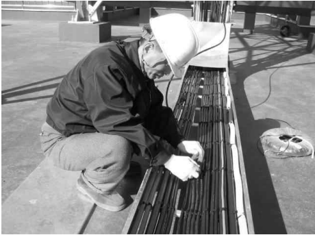
[그림 4-57] 옥외케이블 설치
