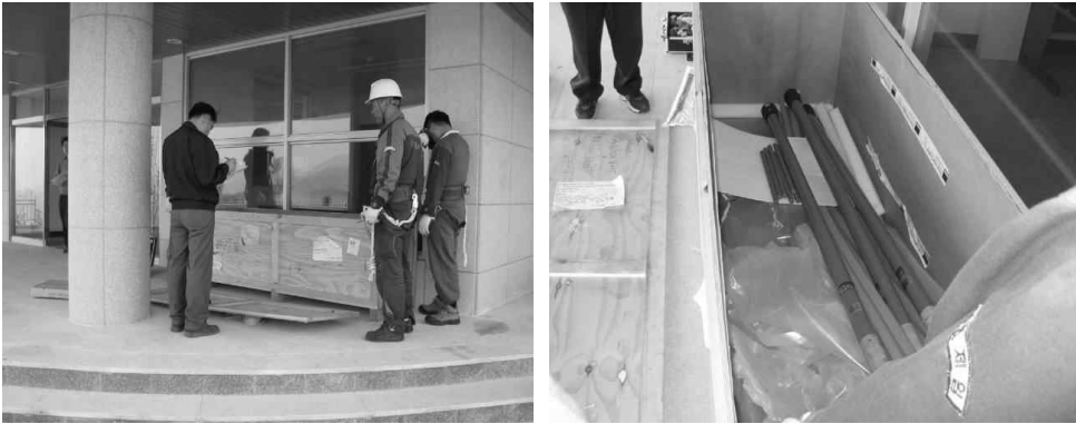
[그림 4-55] VHF 방향탐지 안테나 포장해제 및 품목확인
