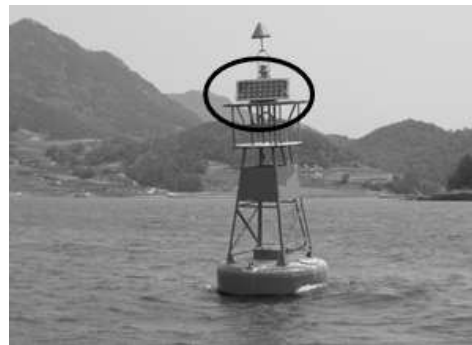
[그림 4-23] 등대에 태양전지 설치
