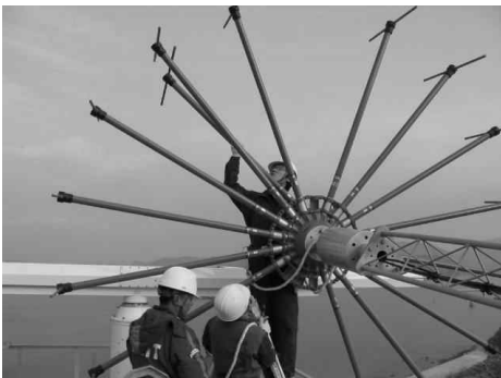
[그림 4-60] VHF대역 방향탐지기 안테나 조립
