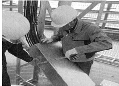
< 케이블 랙 시공 >
