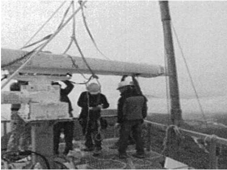
[그림 4-3] 해안 및 해상레이더(안테나)설치
