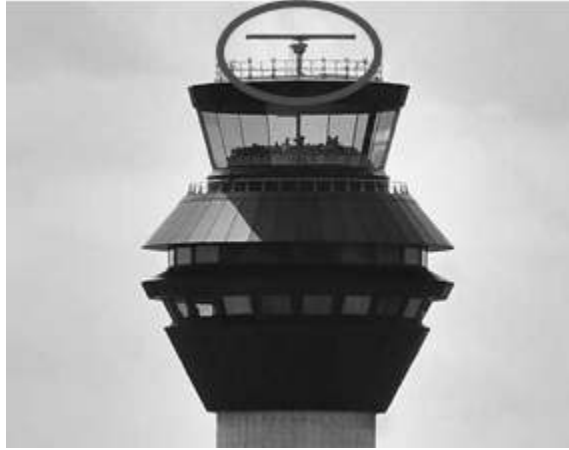
[그림 4-214] 지상감시레이더(ASDE) 설치 완료(예시)
