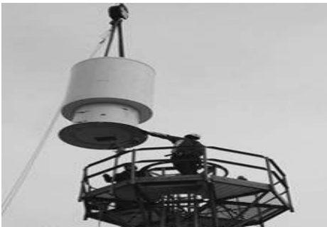
[그림 4-181] 전술항행표지시설(TACAN) 안테나 고정(예시)
