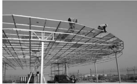
[그림 4-147] 카운터포이즈 철판 깔기(예시)
