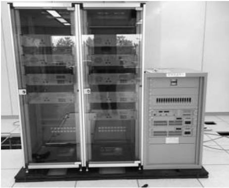
< 멀티트랜시버 장비 설치 >
