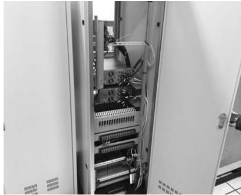
< 멀티트랜시버 전원 및 케이블 설치 >
