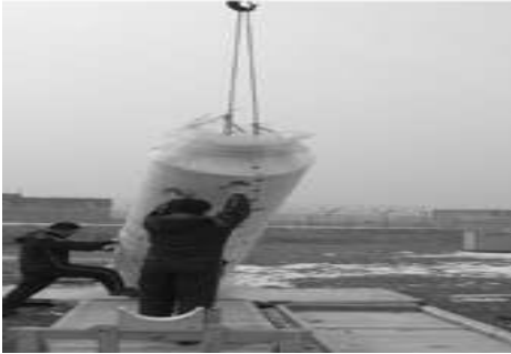
[그림 4-180] 전술항행표지시설(TACAN) 철탑으로 이동(예시)
