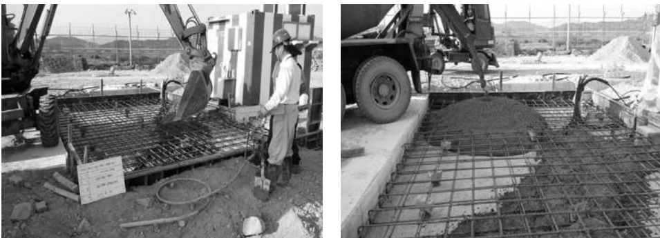
[그림 4-159] 장비실(Shelter) 기초공사 콘크리트 타설(예시)
