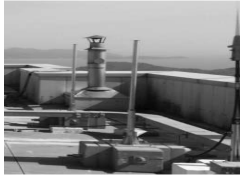
[그림 4-79] 공항정보시설 안테나 Pole 설치(예시)
