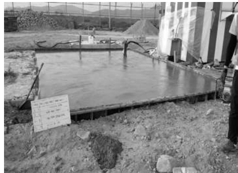
[그림 4-117] 장비실(Shelter) 기초공사 콘크리트 양생(예시)
