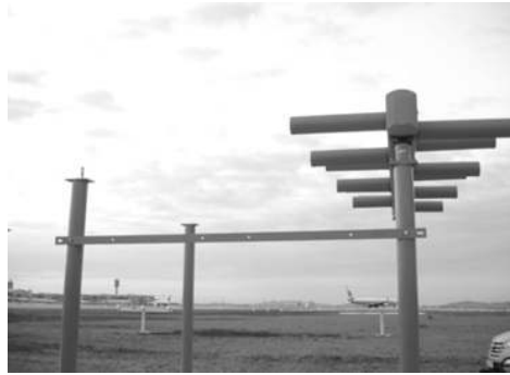
[그림 4-100] 방위각시설 안테나 폴대 설치(예시)
