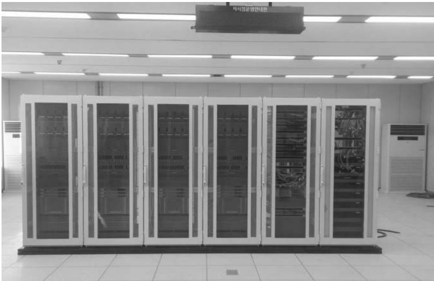
[그림 4-63] 음성통신제어시설(VCCS) 시공완료(예시)
