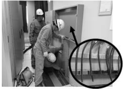
[그림 4-84] 실내 통신케이블 포설(예시)
