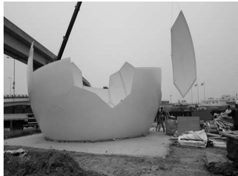
[그림 4-215] 공항지상감시레이더(ASDE) 레이돔 조립(예시)
