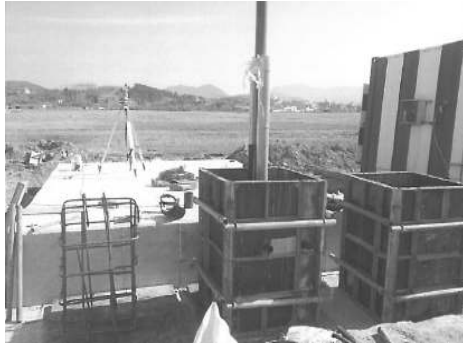
[그림 4-171] 거리측정시설(DME) 기초대 공사(예시)
