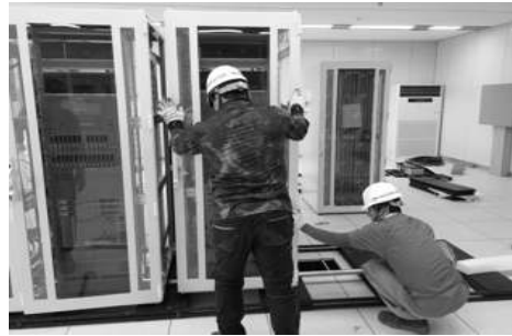
[그림 4-60] 면진장치 위 랙 및 장비 설치(예시)
