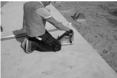
[그림 4-99] 방위각시설 안테나 기초대 설치(예시)
