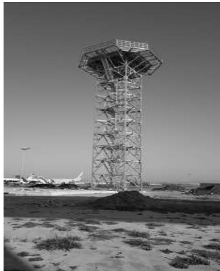
[그림 4-192] 1,2차 감시레이더 철탑 시공 완료(예시)
