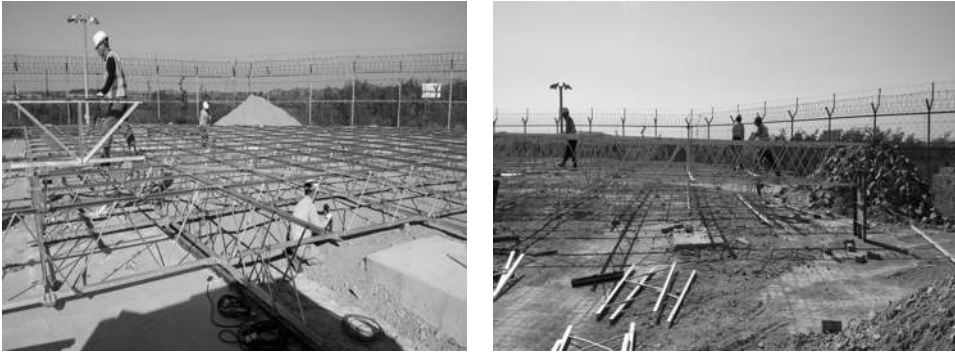
[그림 4-143] 카운터포이즈 조립 II (예시)
