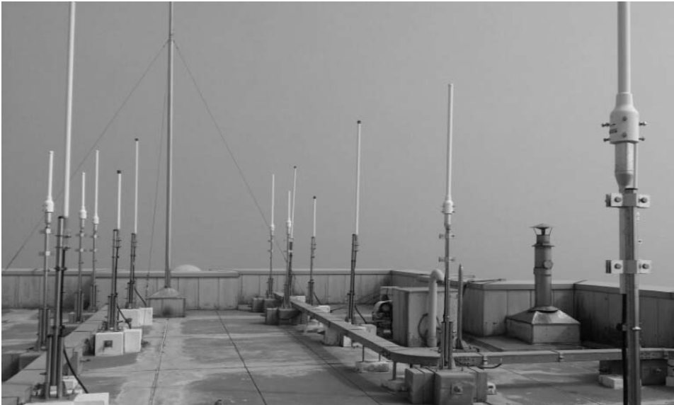
[그림 4-82] 공항정보시설 안테나(Dipole) 설치 완료(예시)
