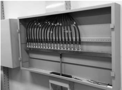
[그림 4-86] 통신케이블 결선 완료(예시)
