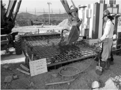
[그림 4-116] 장비실(Shelter) 기초공사 콘크리트 타설(예시)
