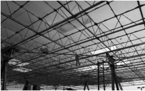
[그림 4-148] 카운터포이즈 설치 완료(예시)
