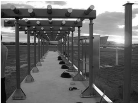
[그림 4-101] 방위각시설 안테나 설치(예시)
