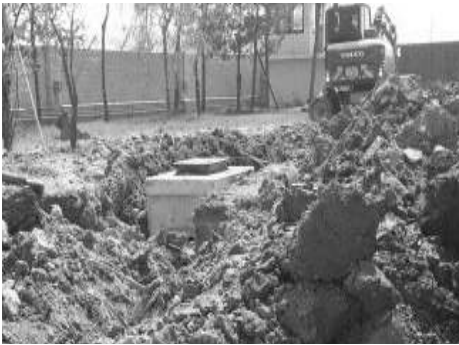
[그림 4-44] 단파이동통신시설(HF Radio) 송신안테나 기초공사(예시)
