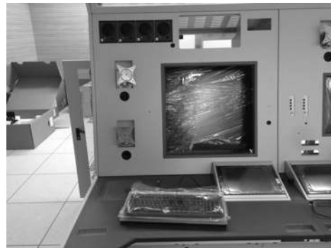
[그림 4-65] 음성통신제어시설(VCCS) 화면 고정(예시)
