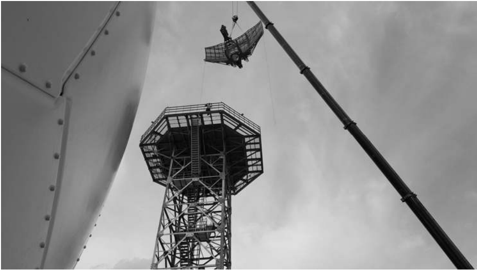
[그림 4-193] 철탑에 1차 감시레이더 설치(예시)
