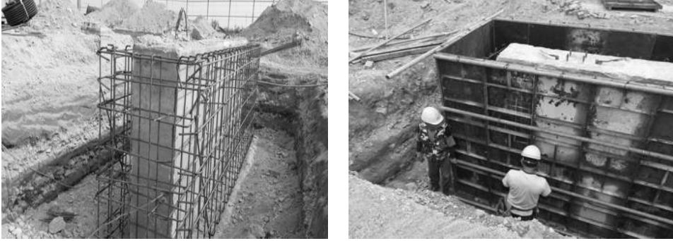
[그림 4-126] 기초대 철근 보강(예시)
