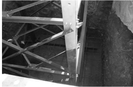
< 기초 바닥 이형철근 >
