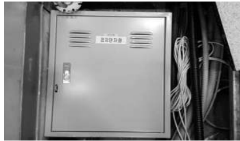
[그림 5-11] 배전반 및 접지단자함 등 설치 검사(예시)
