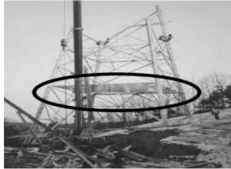
[그림 4-189] 철탑 하부 안전방망 설치(예시)
