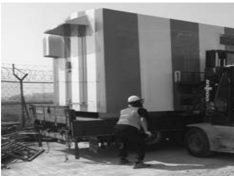
[그림 4-163] 전방향표지시설(VOR) 장비실(Shelter) 설치 완료(예시)
