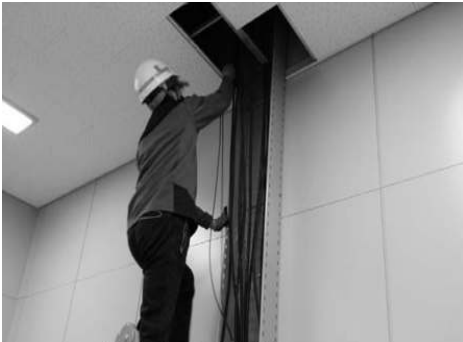
[그림 4-84] 실내 통신케이블 포설(예시)
