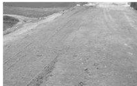
[그림 4-131] 관로공사 되메우기(예시)
