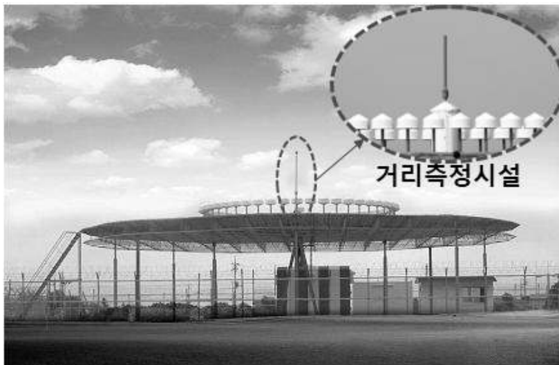
[그림 3-16] 거리측정시설(DME) 개념도(예시)
