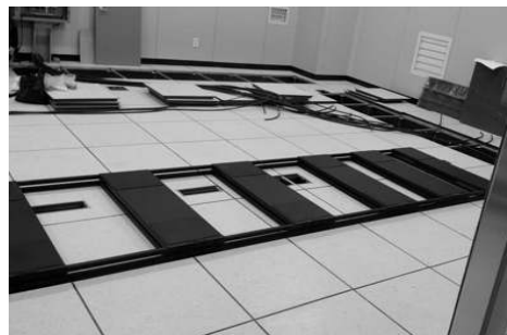
[그림 4-183] 전술항행표지시설(TACAN) 면진장치 설치(예시)
