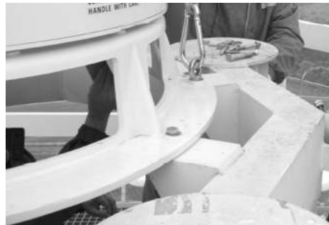
[그림 4-181] 전술항행표지시설(TACAN) 안테나 고정(예시)
