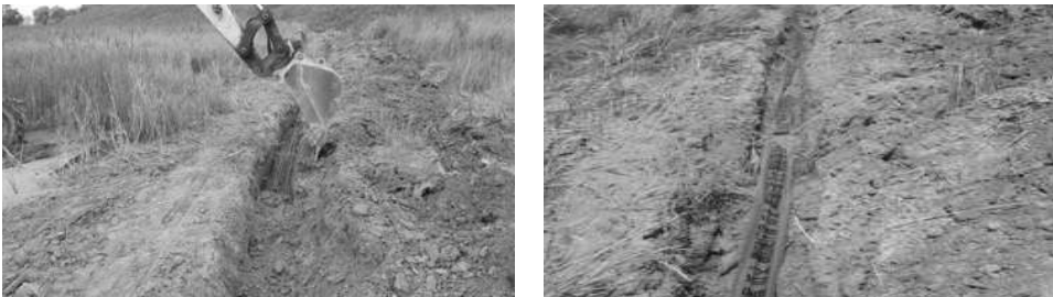
[그림 4-139] 접지공사 터파기 및 경고테이프(예시)
