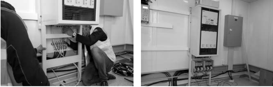
[그림 4-120] 계기착륙시설 장비 시공(예시)
