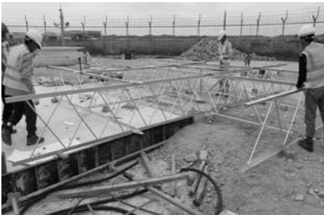
[그림 4-142] 카운터포이즈 조립 I (예시)
