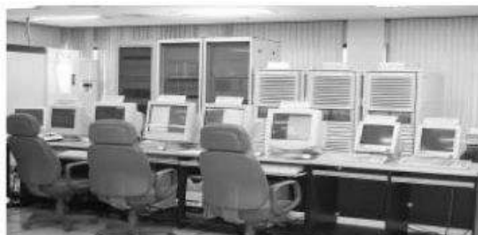
[그림 4-22] 항공고정통신설비 완료(예시)
