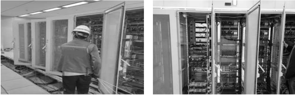
[그림 4-62] 통신케이블 포설 및 케이블링(예시)
