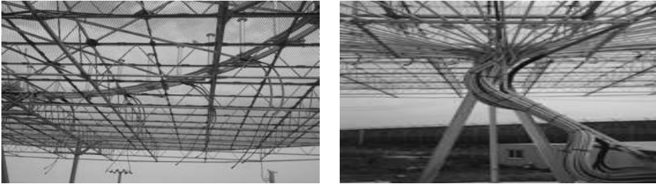
[그림 4-154] 안테나 급전선 포설 완료(예시)
