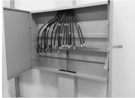
[그림 4-85] 통신케이블 결선작업(예시)
