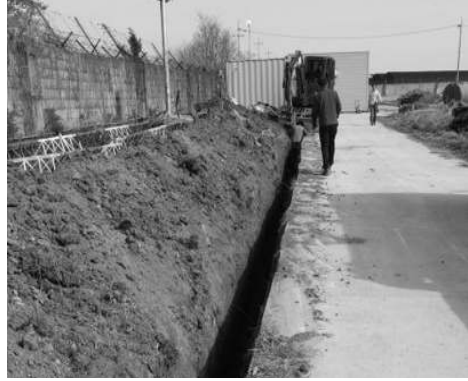
[그림 4-50] 통신관로 인입로 터파기(예시)
