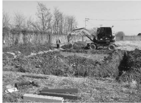
[그림 4-46] 장비실(셸터) 터파기(예시)
