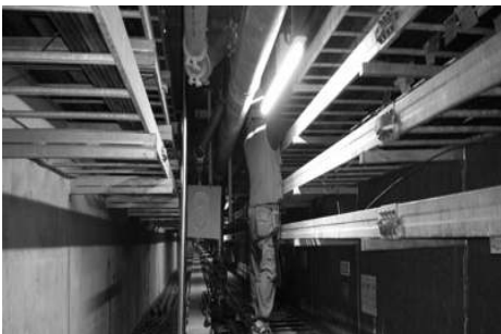
[그림 4-133] 공동구 광케이블 포설(예시)
