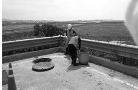
[그림 4-132] 광케이블 맨홀 포설(예시)
