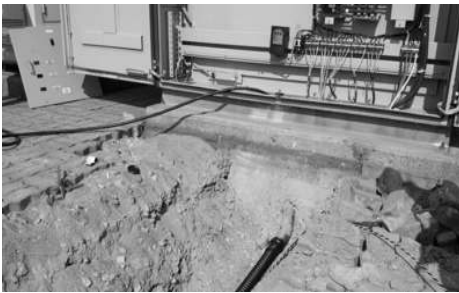
[그림 4-130] 통신관로 및 접지 등 포설(예시)
