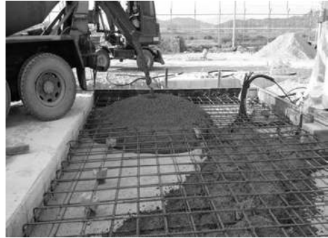
[그림 4-116] 장비실(Shelter) 기초공사 콘크리트 타설(예시)
