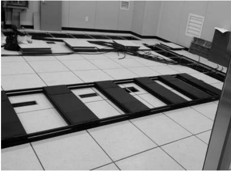
[그림 4-206] 면진장치 위에 랙 및 장비 설치(예시)
