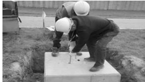
[그림 4-105] 위치표지시설 기초대 설치(예시)
