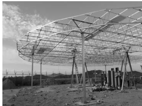
[그림 4-146] 카운터포이즈 철탑 조립(예시)
