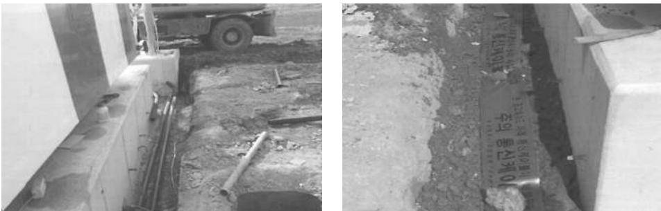
[그림 4-170] 거리측정시설(DME) 관로 및 통신케이블 공사(예시)
