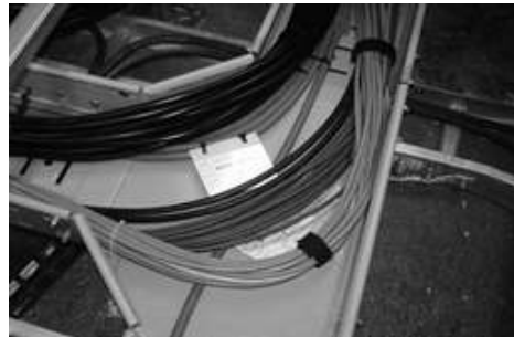
[그림 4-61] 통신케이블 이중마루 및 트레이 설치(예시)
