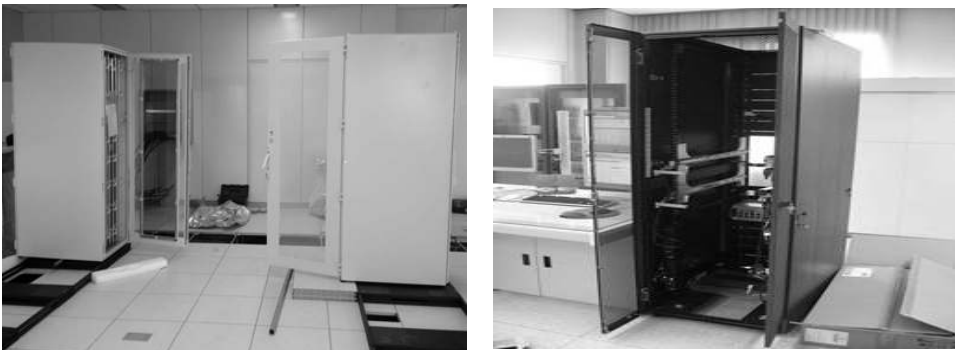
[그림 4-167] 면진장치 위에 랙 및 장비 설치(예시)
