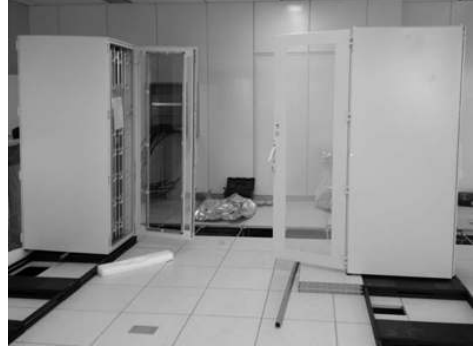
[그림 4-206] 면진장치 위에 랙 및 장비 설치(예시)
