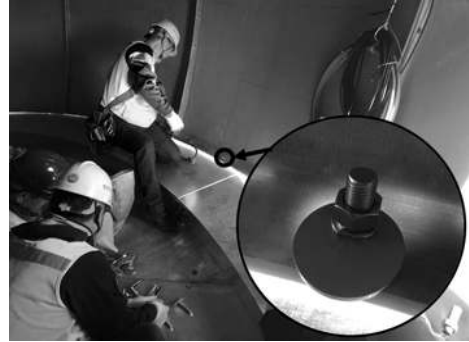
[그림 4-216] 공항지상감시레이더(ASDE) 레이돔 설치(예시)
