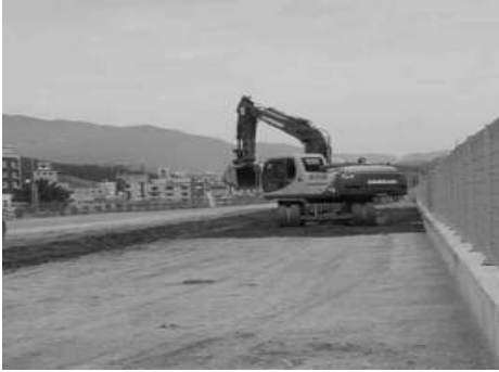
[그림 4-124] 기초대 터파기(예시)
