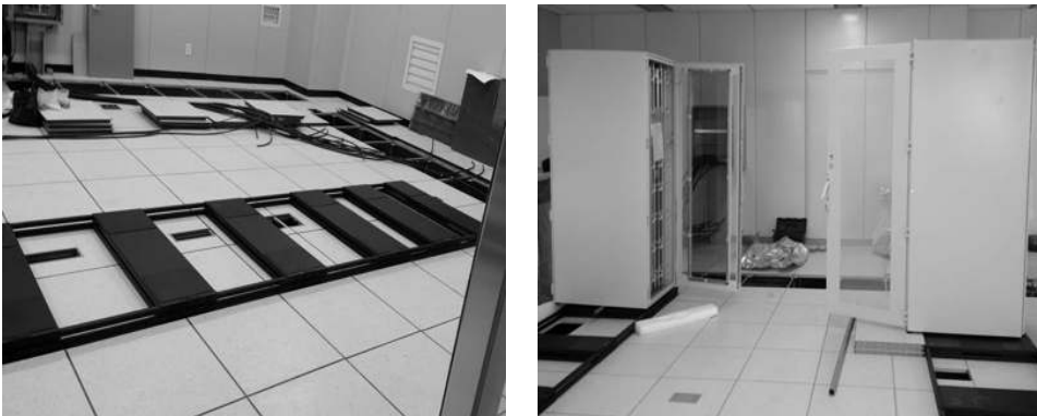
[그림 4-55] 면진장치 위에 랙 및 장비 설치(예시)
