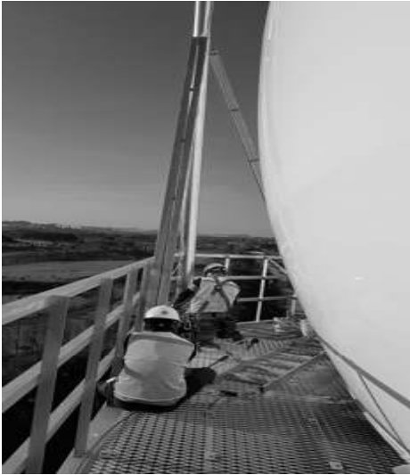
[그림 4-199] 1,2차 감시레이더 통신케이블 설치(예시)
