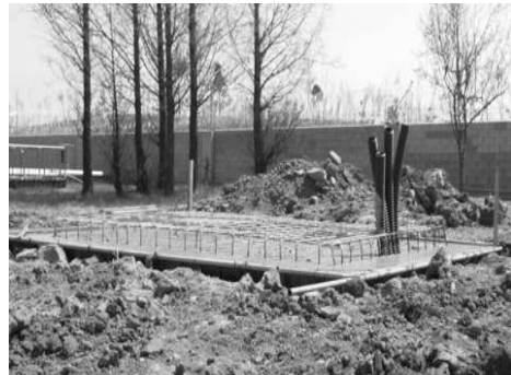
[그림 4-47] 장비실(셸터) 거푸집 콘크리트 양생(예시)
