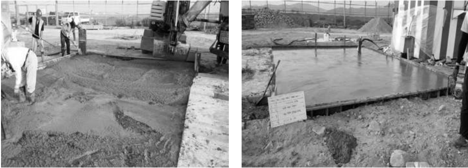
[그림 4-160] 장비실(Shelter) 기초공사 콘크리트 양생(예시)
