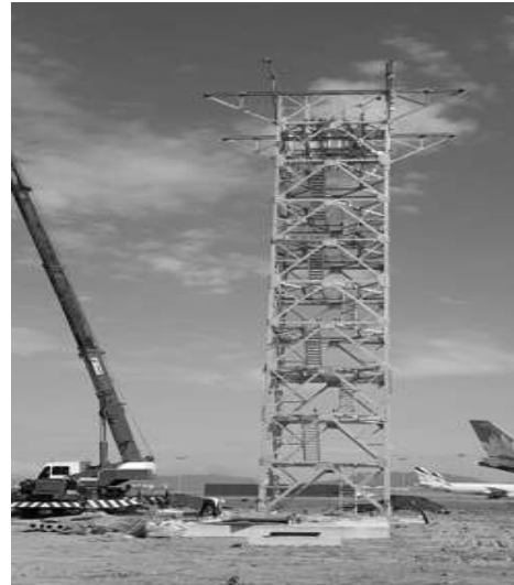
[그림 4-190] 1,2차 감시레이더 철탑 조립 II (예시)
