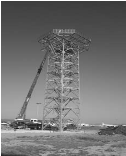
[그림 4-192] 1,2차 감시레이더 철탑 시공 완료(예시)
