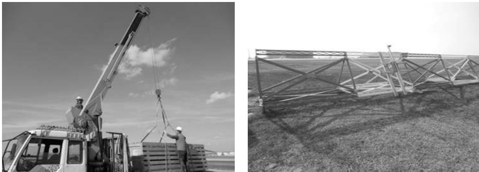
[그림 4-108] 활공각제공시설 공중선주 설치(예시)
