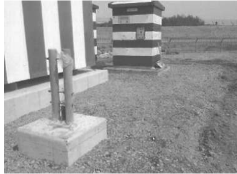
[그림 4-171] 거리측정시설(DME) 기초대 공사(예시)
