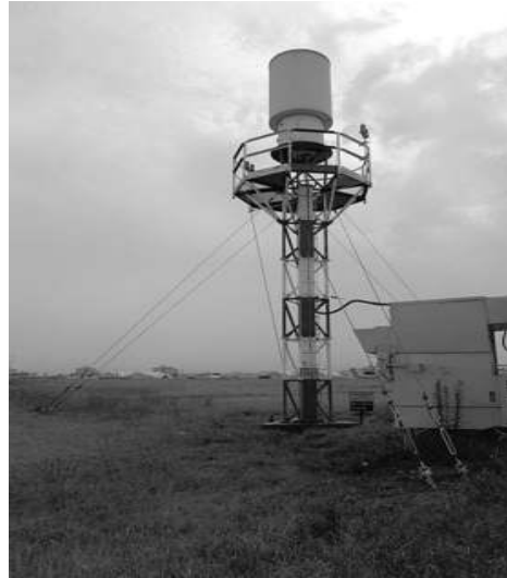
[그림 4-182] 전술항행표지시설(TACAN) 설치 완료(예시)
