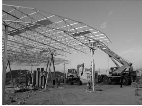
[그림 4-145] 크레인으로 카운터포이즈 이동(예시)
