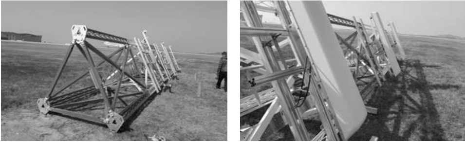
[그림 4-109] 활공각제공시설 안테나 설치(예시)
