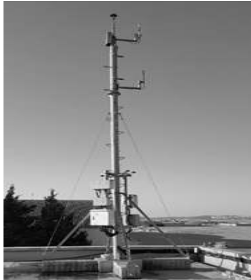
[그림 4-227] 다변측정감시시설(MLAT)설치 완료(예시)
