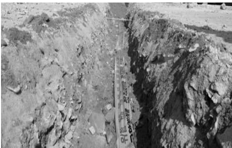
[그림 4-131] 관로공사 되메우기(예시)
