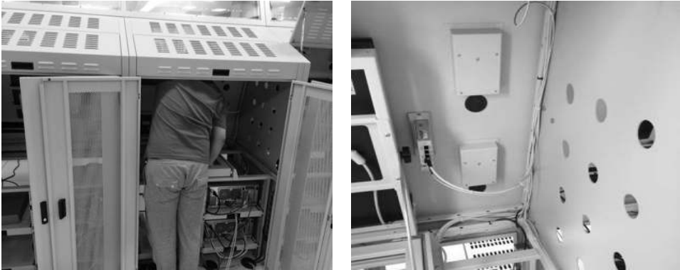
[그림 4-69] 음성통신제어시설(VCCS) 케이블 설치(예시)
