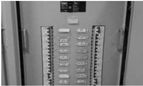
[그림 5-11] 배전반 및 접지단자함 등 설치 검사(예시)
