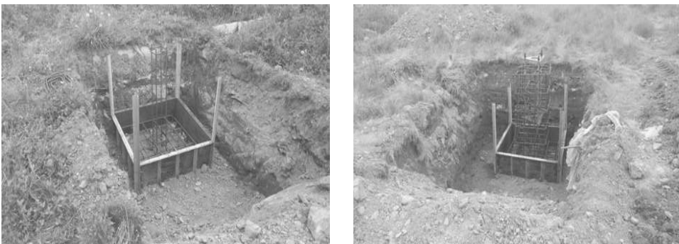
[그림 4-43] HF 수신안테나 기초공사(예시)
