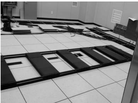
[그림 4-202] 면진장치 위에 랙 및 장비 설치(예시)
