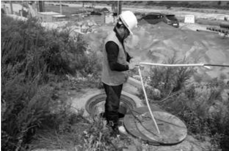
[그림 4-132] 광케이블 맨홀 포설(예시)
