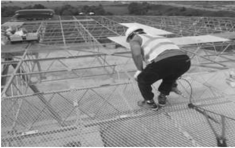
[그림 4-147] 카운터포이즈 철판 깔기(예시)
