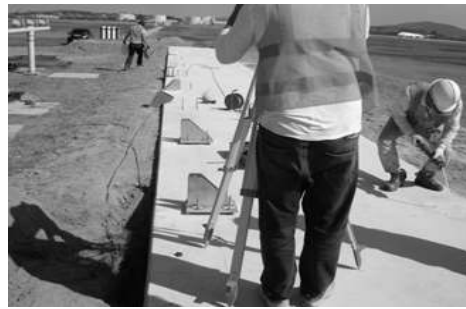
[그림 4-98] 방위각시설 안테나 기초대 위치 측량(예시)
