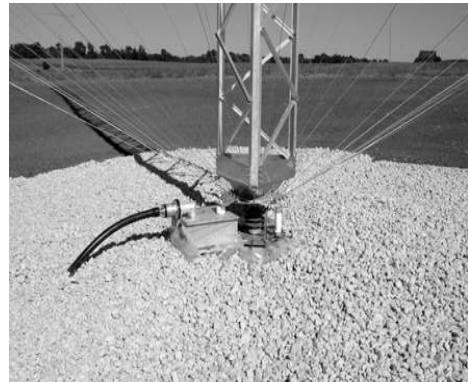
[그림 4-51] 단파이동통신시설 송·수신기 케이블 연결(예시)
