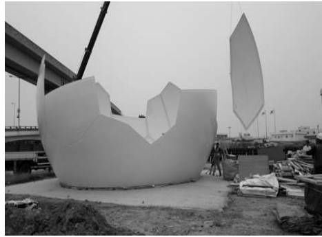
[그림 4-197] 1,2차 감시레이더 레이돔 조립(예시)
