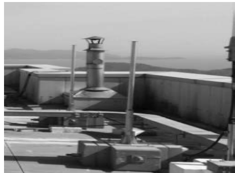
[그림 4-32] 단거리이동통신시설(VHF/UHF Radio) 안테나 Pole 설치(예시)
