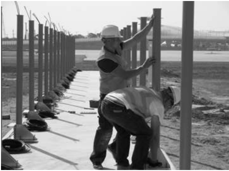
[그림 4-100] 방위각시설 안테나 폴대 설치(예시)
