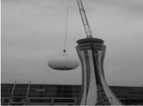
[그림 4-216] 공항지상감시레이더(ASDE) 레이돔 설치(예시)
