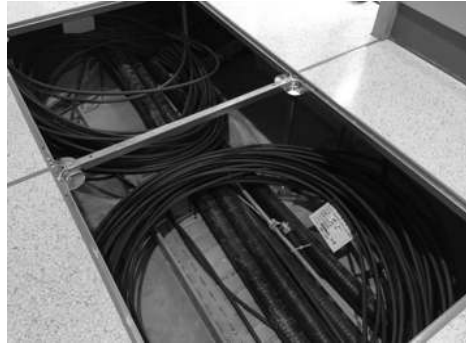
[그림 4-134] 장비실 통신케이블 포설(예시)
