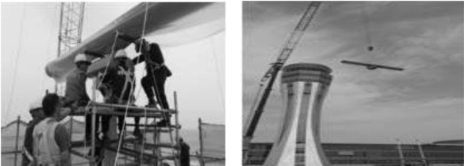
[그림 4-211] 지상감시레이더 운송(예시)
