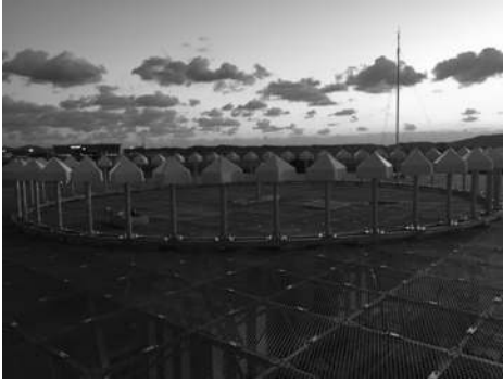
[그림 4-152] 전방향표지시설 안테나 설치(예시)
