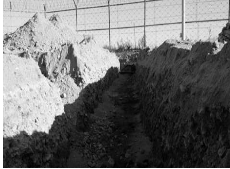
[그림 4-124] 기초대 터파기(예시)
