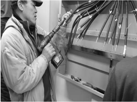
[그림 4-85] 통신케이블 결선작업(예시)
