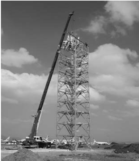
[그림 4-190] 1,2차 감시레이더 철탑 조립 II (예시)
