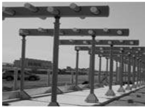
[그림 4-101] 방위각시설 안테나 설치(예시)
