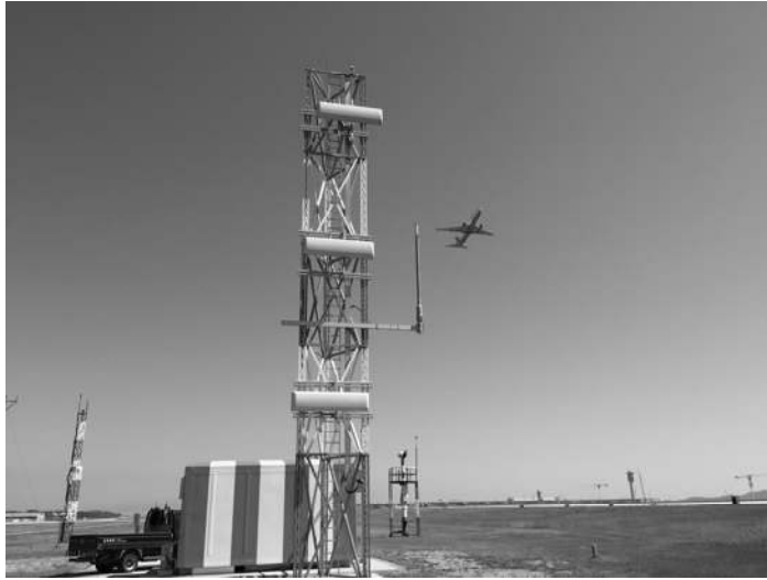
[그림 3-10] 활공각장비(예시)
