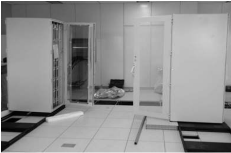
[그림 4-60] 면진장치 위 랙 및 장비 설치(예시)
