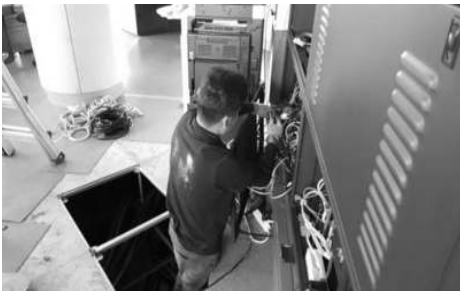
[그림 4-223] 공항지상감시레이더 콘솔 모니터 설치(예시)
