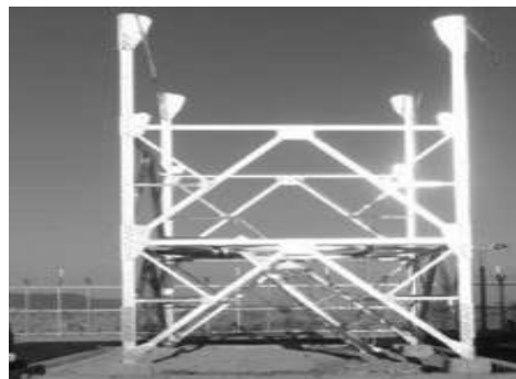
[그림 4-188] 1,2차 감시레이더 철탑 조립 I (예시)
