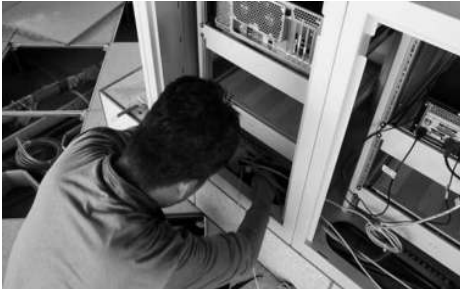
[그림 4-222] 공항지상감시레이더 콘솔 및 장비 설치(예시)
