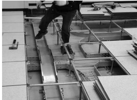
[그림 4-218] 공항지상감시레이더(ASDE) 면진장치 설치(예시)
