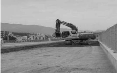
[그림 4-129] 관로공사 터파기(예시)
