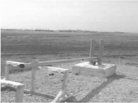
[그림 4-173] 거리측정시설(DME) 안테나 설치(예시)
