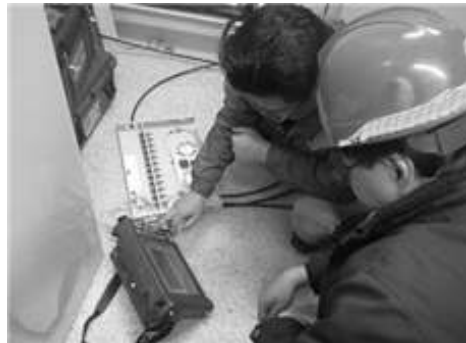
[그림 4-135] 광분배함 설치 및 광케이블 시험(예시)
