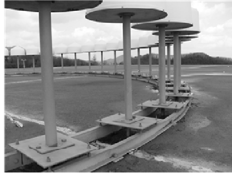
[그림 4-152] 전방향표지시설 안테나 설치(예시)
