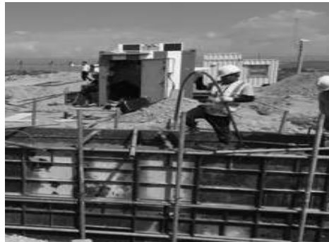
[그림 4-125] 기초대 거품집 설치 및 콘크리트 타설(예시)
