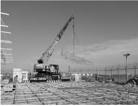
[그림 4-145] 크레인으로 카운터포이즈 이동(예시)
