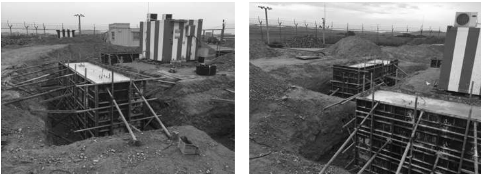
[그림 4-127] 기초대 콘크리트 양생(예시)
