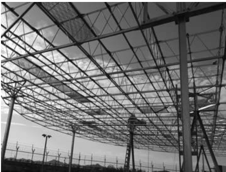
[그림 4-146] 카운터포이즈 철탑 조립(예시)
