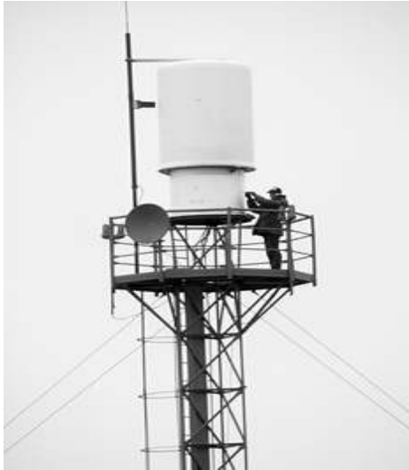
[그림 4-182] 전술항행표지시설(TACAN) 설치 완료(예시)
