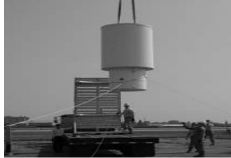
[그림 4-180] 전술항행표지시설(TACAN) 철탑으로 이동(예시)
