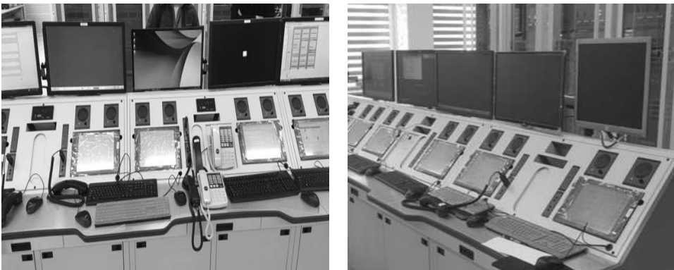
[그림 4-70] 음성통신제어시설(VCCS) 콘솔 설치 완료(예시)
