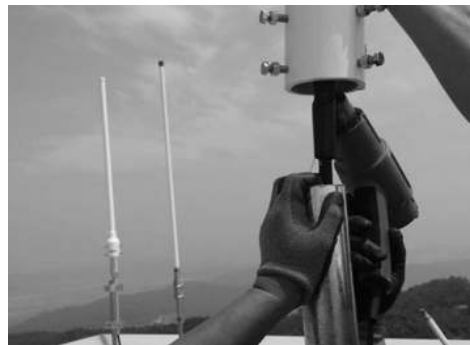
[그림 4-80] 공항정보시설(Dipole) 안테나 설치(예시)
