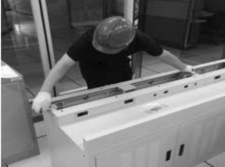
[그림 4-64] 음성통신제어시설(VCCS) 바디프레임 설치(예시)
