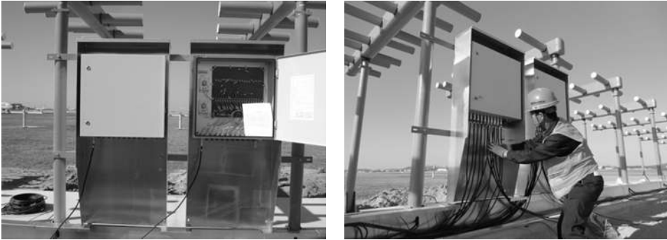
[그림 4-102] 방위각시설 안테나 장비 설치(예시)
