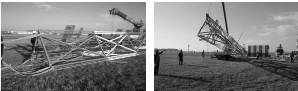
[그림 4-111] 활공각제공시설 공중선주 설치(예시)
