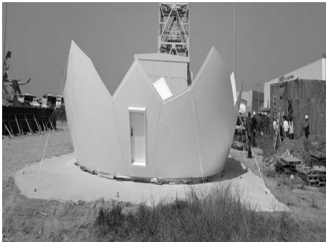
[그림 4-215] 공항지상감시레이더(ASDE) 레이돔 조립(예시)
