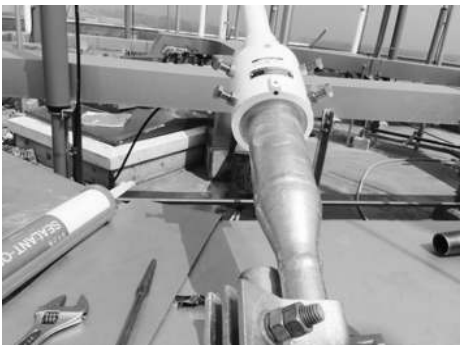
[그림 4-174] 거리측정시설(DME) 안테나 설치(예시)
