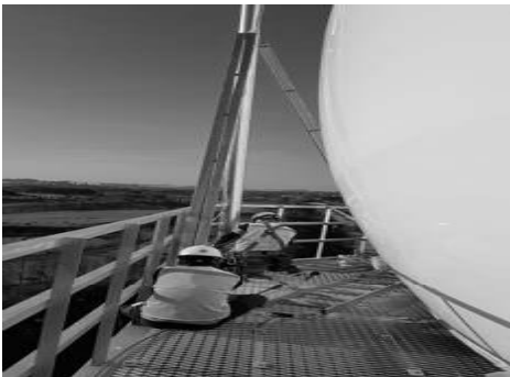
[그림 4-217] 공항지상감시레이더(ASDE) 통신케이블 설치(예시)
