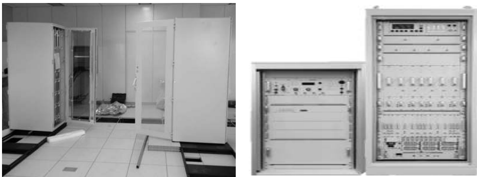
[그림 4-184] 면진장치 위에 랙 및 장비 설치(예시)
