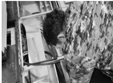
[그림 4-219] 관제탑 접지, 전원 및 통신케이블 시공(예시)
