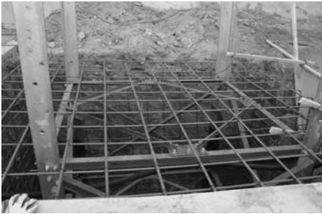
< 기초 이형철근 상부 >
