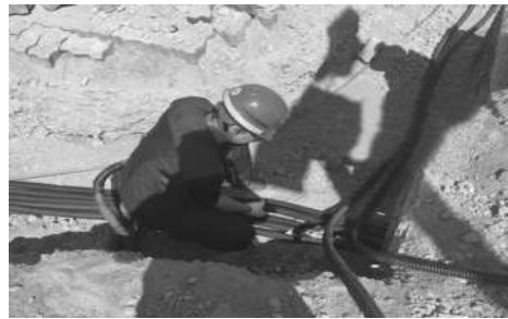
[그림 4-130] 통신관로 및 접지 등 포설(예시)
