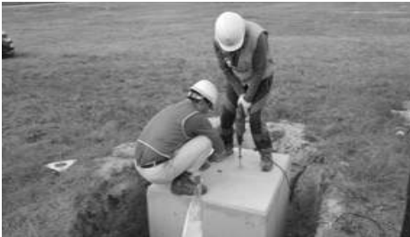
[그림 4-105] 위치표지시설 기초대 설치(예시)
