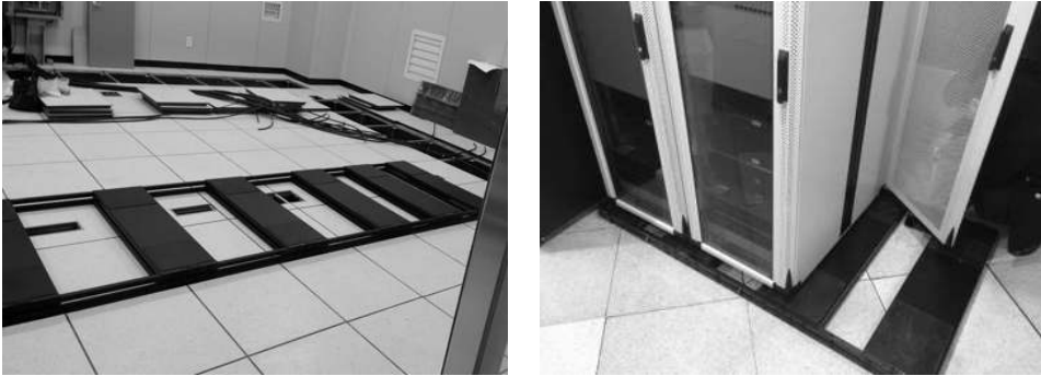
[그림 4-220] 면진장치 위에 랙 및 장비 설치(예시)
