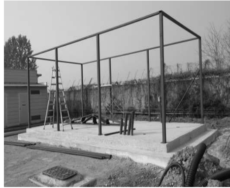
[그림 4-48] 장비실(쉘터) 철근 골격 고정(예시)
