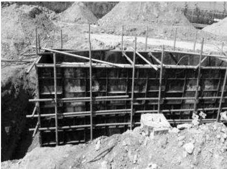
[그림 4-125] 기초대 거품집 설치 및 콘크리트 타설(예시)
