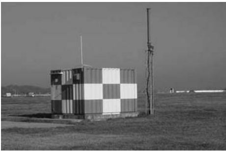
< 지상에 거리측정시설 설치 >
