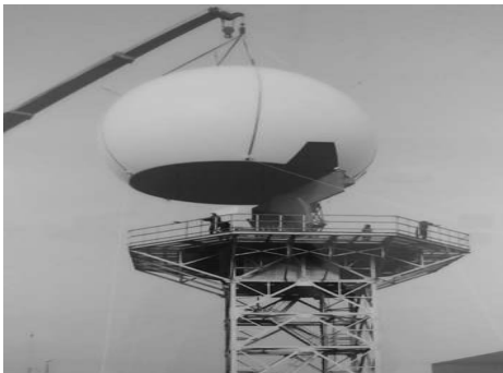
[그림 4-198] 1차, 2차 감시레이더 레이돔 설치(예시)
