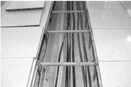
[그림 4-61] 통신케이블 이중마루 및 트레이 설치(예시)
