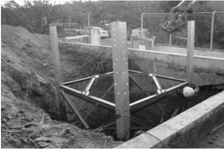
< 기초 철탑조립 전경 >
