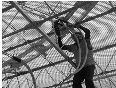
[그림 4-153] Side band 안테나 케이블 배관 및 케이블 설치(예시)
