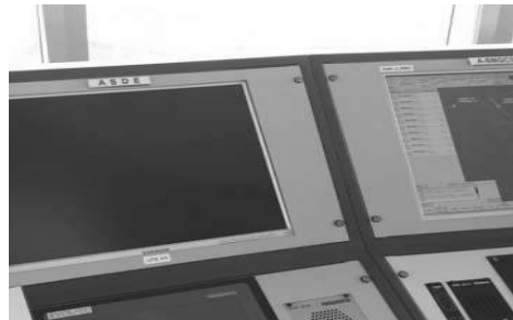
[그림 4-223] 공항지상감시레이더 콘솔 모니터 설치(예시)
