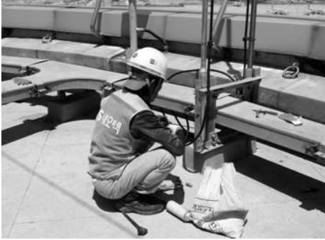
[그림 4-83] 안테나 통신케이블 설치(예시)
