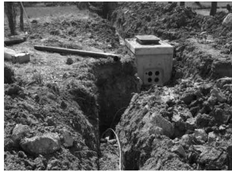
[그림 4-44] 단파이동통신시설(HF Radio) 송신안테나 기초공사(예시)
