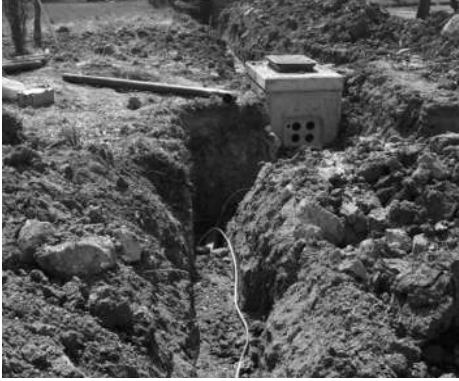
[그림 4-50] 통신관로 인입로 터파기(예시)
