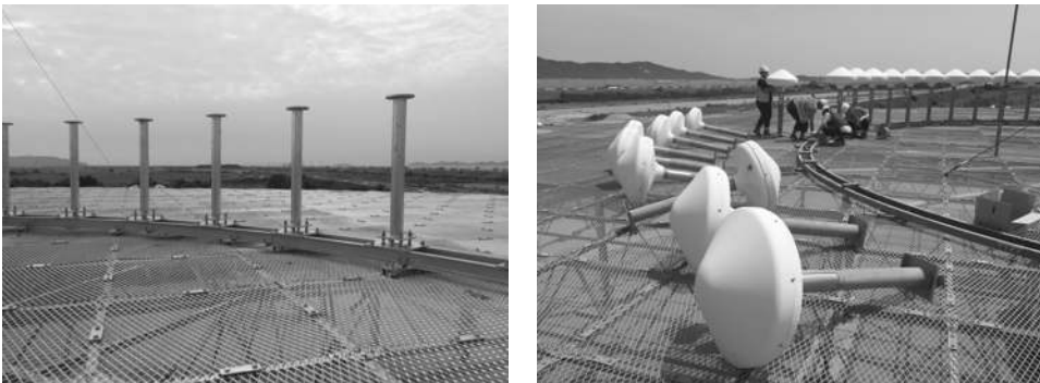
[그림 4-151] 전방향표지시설 안테나 Pole 설치(예시)
