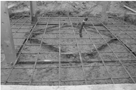
< 기초 콘크리트 타설 >
