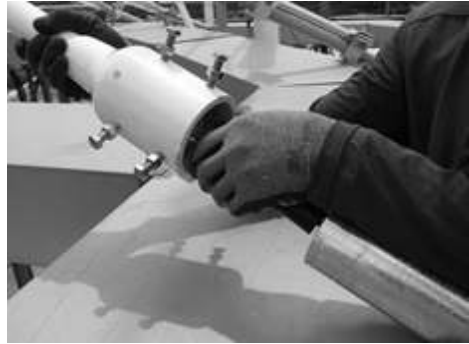
[그림 4-173] 거리측정시설(DME) 안테나 설치(예시)
