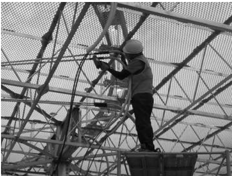
[그림 4-153] Side band 안테나 케이블 배관 및 케이블 설치(예시)
