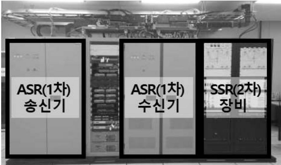
[그림 4-203] 1,2차 감시레이더 장비 설치(예시)
