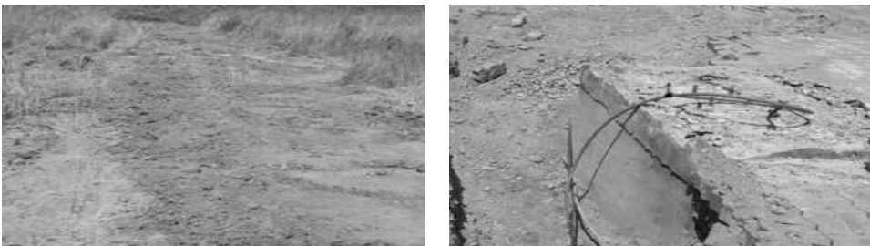
[그림 4-140] 접지공사 되메이기 및 접지 케이블(예시)
