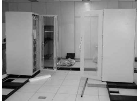
[그림 4-202] 면진장치 위에 랙 및 장비 설치(예시)
