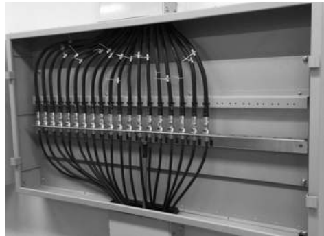
[그림 4-86] 통신케이블 결선 완료(예시)
