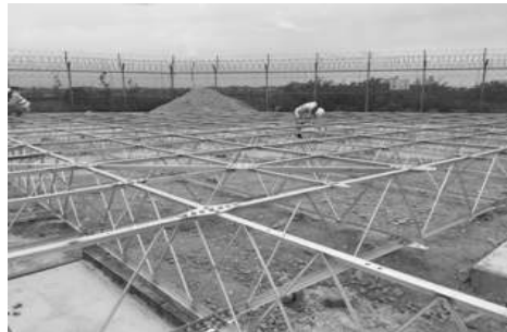
[그림 4-142] 카운터포이즈 조립 I (예시)
