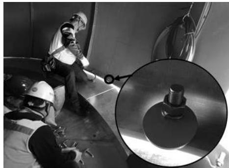
[그림 4-198] 1차, 2차 감시레이더 레이돔 설치(예시)
