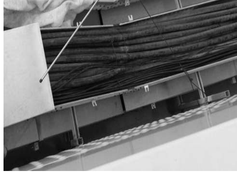
[그림 4-83] 안테나 통신케이블 설치(예시)
