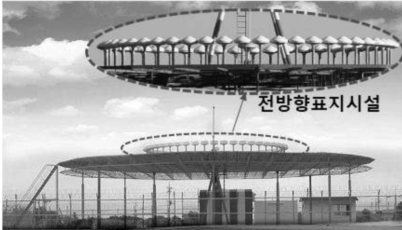
[그림 3-14] 전방향표지시설 구성도(예시)
