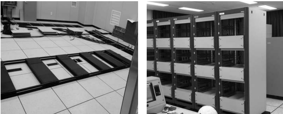
[그림 4-36] 면진장치 위에 랙 및 장비 설치(예시)
