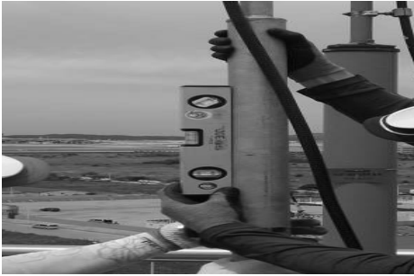
[그림 4-175] 거리측정시설(DME) 안테나 고정(예시)
