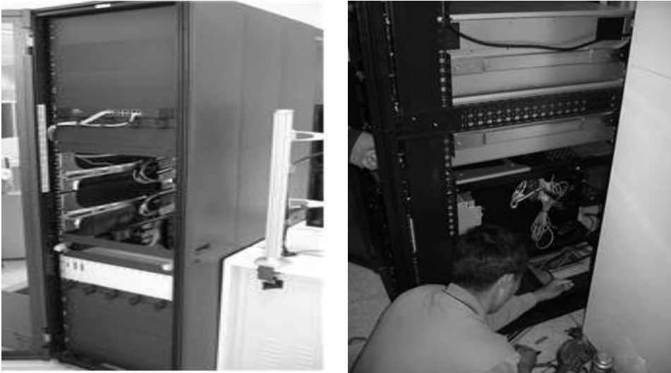
[그림 4-90] 공항정보방송시설(ATIS) 랙 설치(예시)
