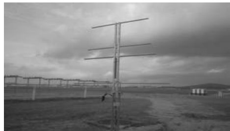
[그림 4-106] 위치표지시설 안테나 설치(예시)
