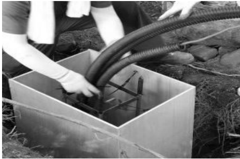
< Pole 거푸집 및 접지공사 >
