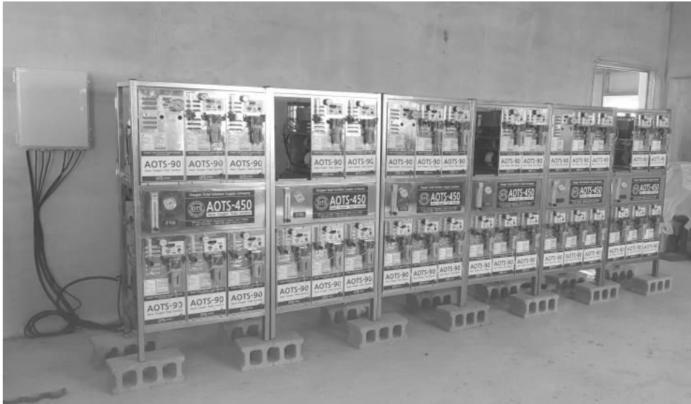
[그림 4-67] 소형 산소발생기 설치(예시)
