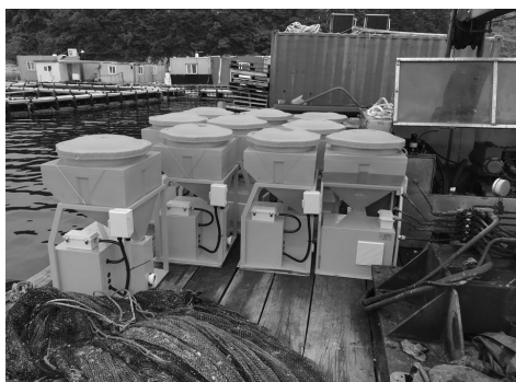
< 양식장 장비 안테나 설치 >
