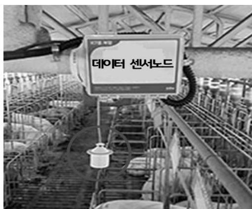
[그림 4-45] 온도센서 설치(예시)
