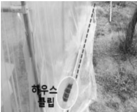
[그림 4-17] 측면 비닐 끝단에 자동폐기와 연결할 파이프 결합(예시)
