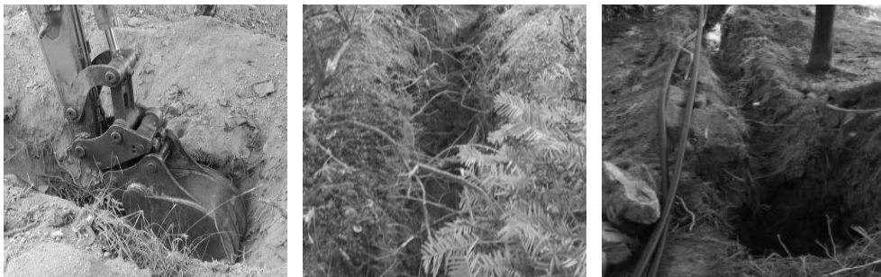
< CCTV Pole 터파기 >
