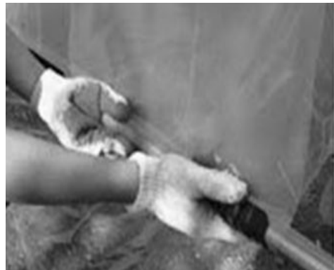
[그림 4-17] 측면 비닐 끝단에 자동폐기와 연결할 파이프 결합(예시)
