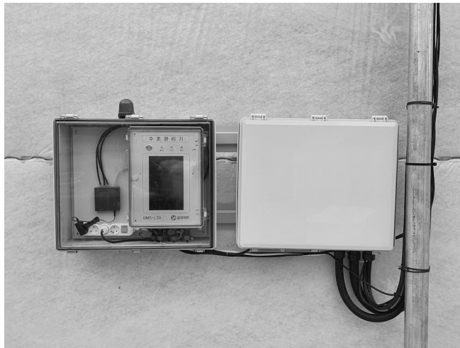
[그림 4-60] 옥외 수조관리기 설치 완료(예시)
