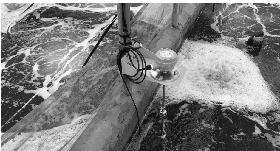
[그림 4-64] 수위측정센서 설치 완료(예시)
