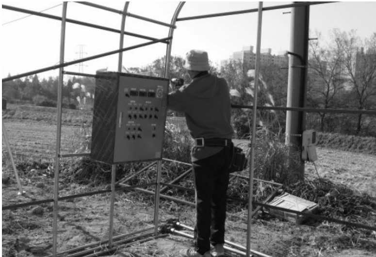
[그림 4-21] 자동개폐기 제어기(예시)
