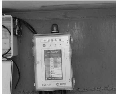
<수조벽에 수조관리기 설치>
