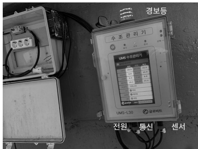
[그림 4-58] 옥내 수조관리기 설치 완료(예시)
