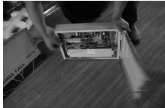
< 중앙제어기 케이블 설치 >
