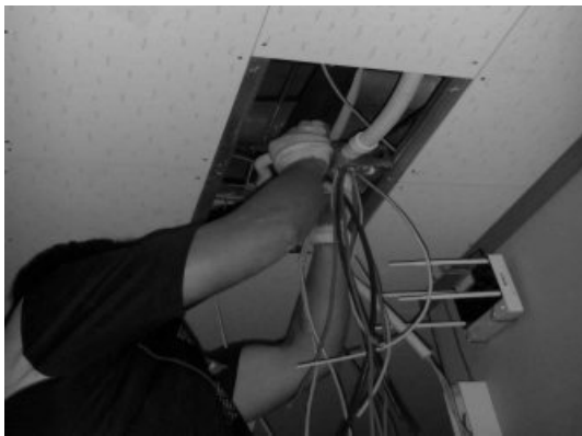
< 복도등 케이블 설치 >
