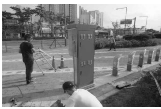
[그림 4-72] 무인대여 자전거 키오스크(Kiosk) 커버 부착(예시)
