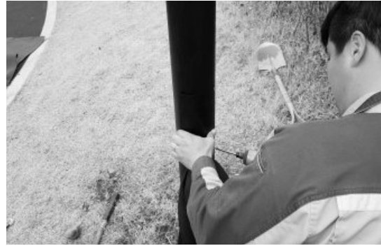
[그림 4-100] 스마트 미세먼지신호등 제어함 고정(예시)
