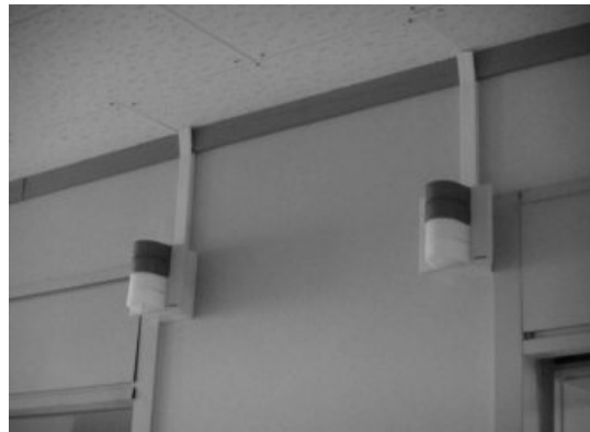
< 복도등 설치 완료 >
