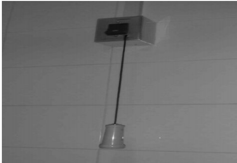
[그림 4-8] 주 수신기 설치(예시)
