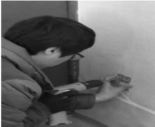
< 가스센서 브라켓 설치 >
