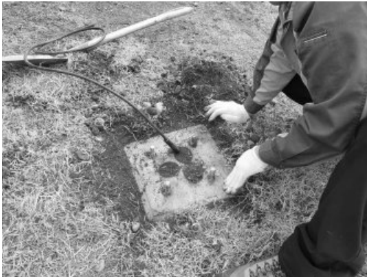
< 콘크리트 기초대 앵커볼트 >
