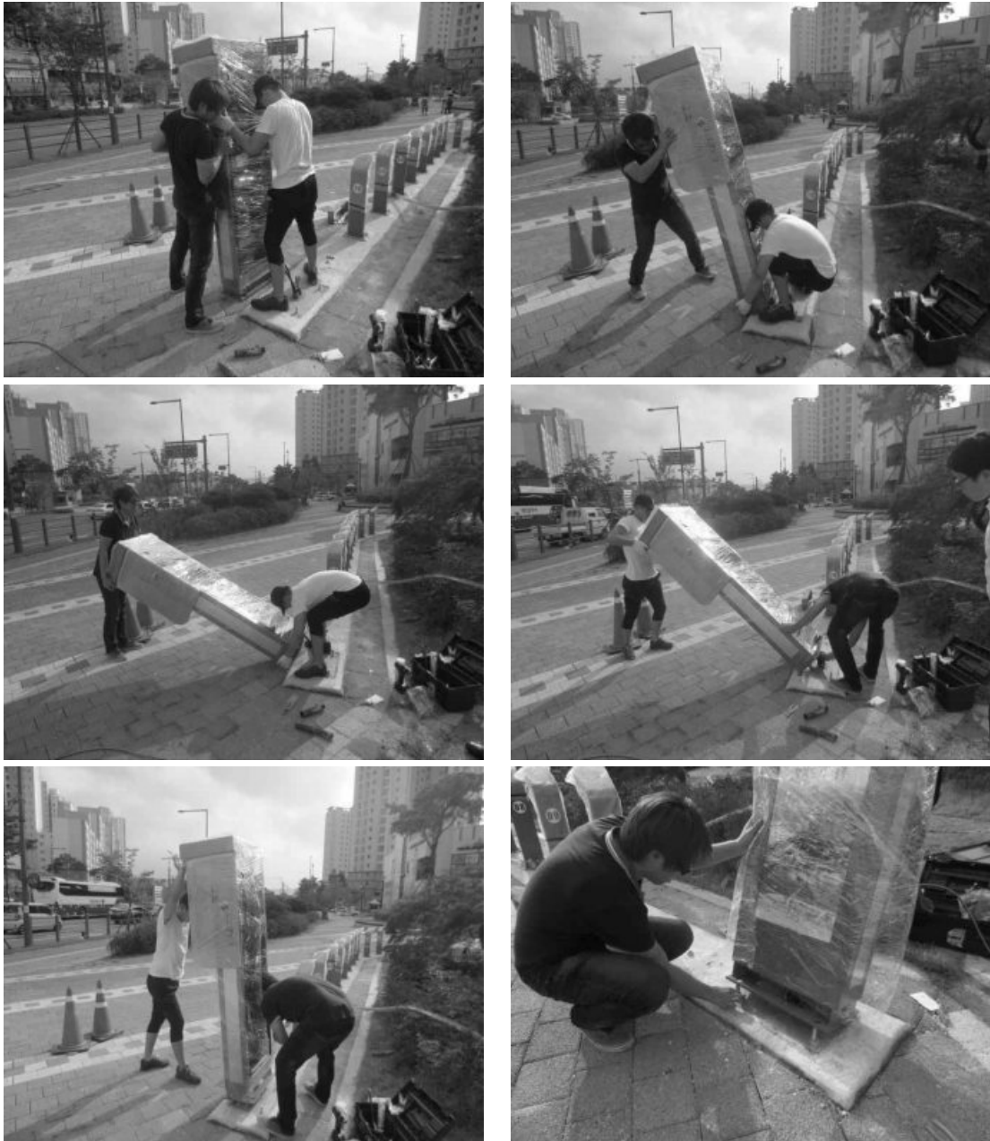
[그림 4-66] 무인대여 자전거 키오스크(Kiosk) 고정(예시)
