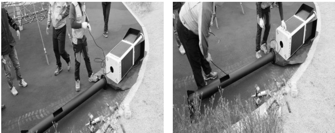
[그림 4-95] 스마트 미세먼지신호등 통신 및 전원케이블 배치(예시)
