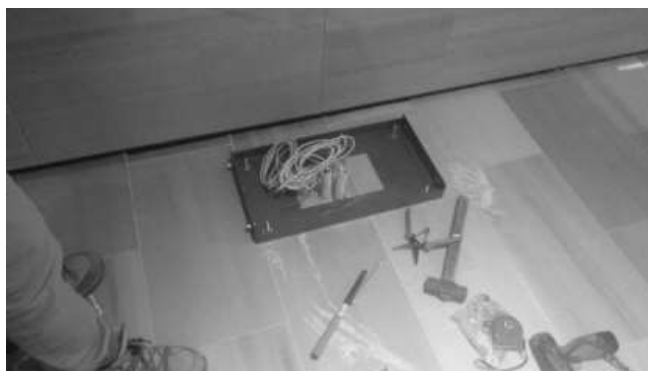
[그림 4-13] 기초대 앵카볼트 고정(예시)
