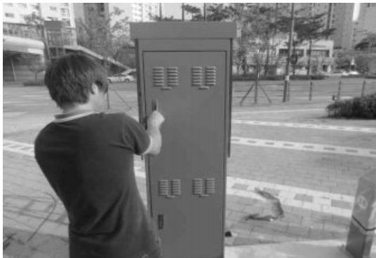
[그림 4-72] 무인대여 자전거 키오스크(Kiosk) 커버 부착(예시)
