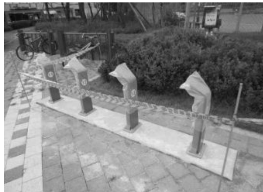
[그림 4-63] 자전거 무인대여 거치대 설치(예시)
