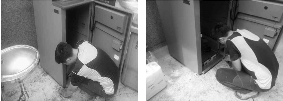
[그림 4-106] 고정판에 쓰레기종량제시스템 고정(예시)
