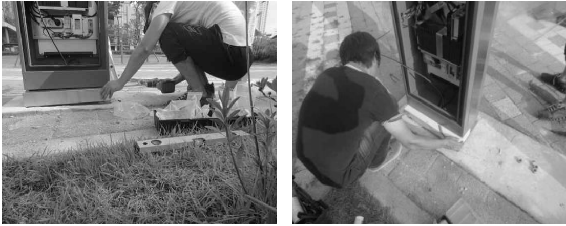
[그림 4-69] 무인대여 자전거 키오스크(Kiosk) 받침대 설치(예시)
