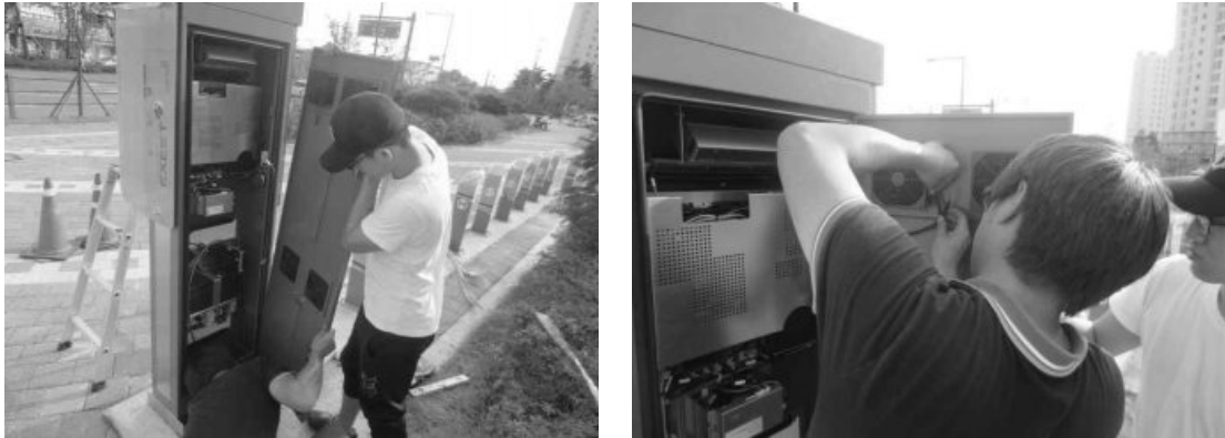
[그림 4-73] 자전거 무인대여 시스템 키오스크(Kiosk) 환풍기 설치(예시)
