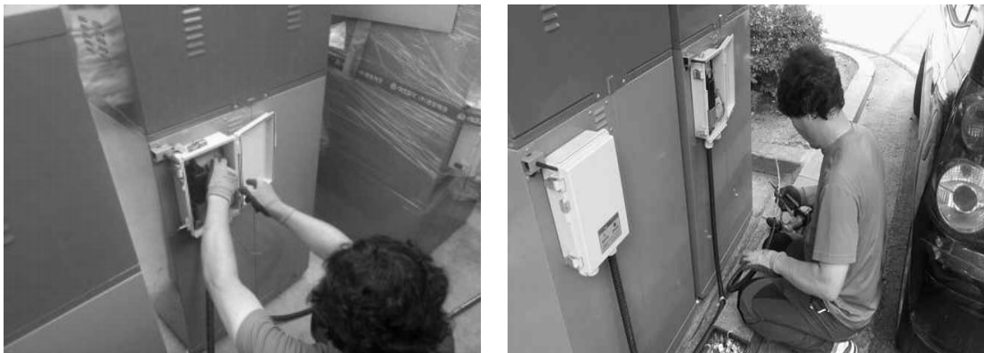
[그림 4-107] 쓰레기종량제시스템 전원 및 통신케이블 연결(예시)
