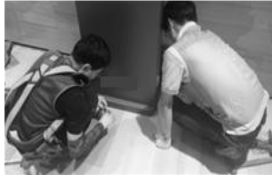
[그림 4-16] 진료시스템 키오스크(Kiosk) 볼트로 고정(예시)
