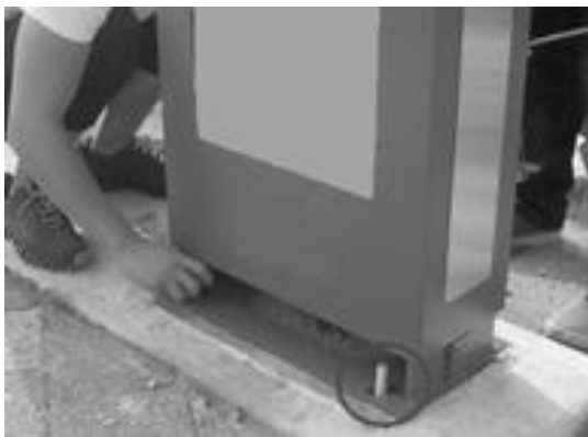
[그림 4-68] 무인대여 자전거 키오스크(Kiosk) 양카볼트 고정(예시)
