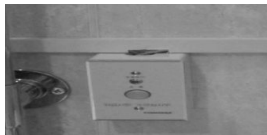
< 위급 호출기 설치 완료 >
