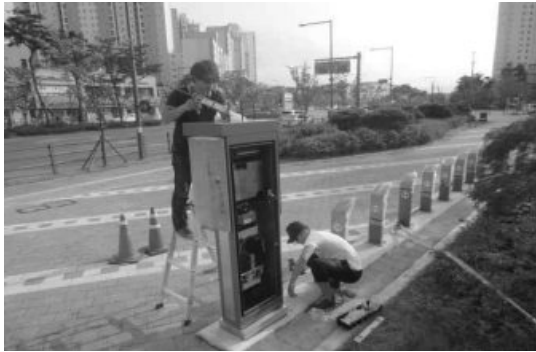
[그림 4-71] 무인대여 자전거 키오스크(Kiosk) 무선장치 설치(예시)
