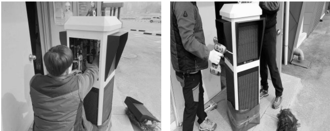
[그림 4-93] 스마트 미세먼지신호등 본체 조립(예시)
