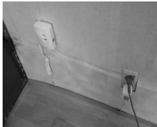
< 가스센서 설치 완료 >
