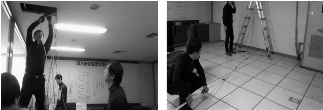
[그림 4-78] 대기오염측정시스템 케이블 포설(예시)
