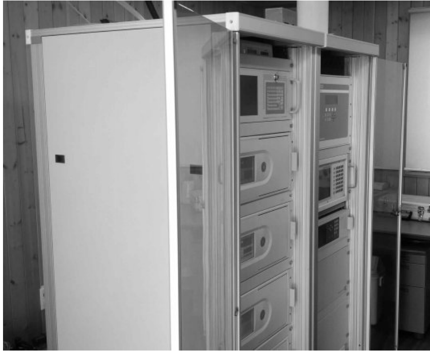
[그림 4-81] 대기오염측정시스템 랙 고정(예시)
