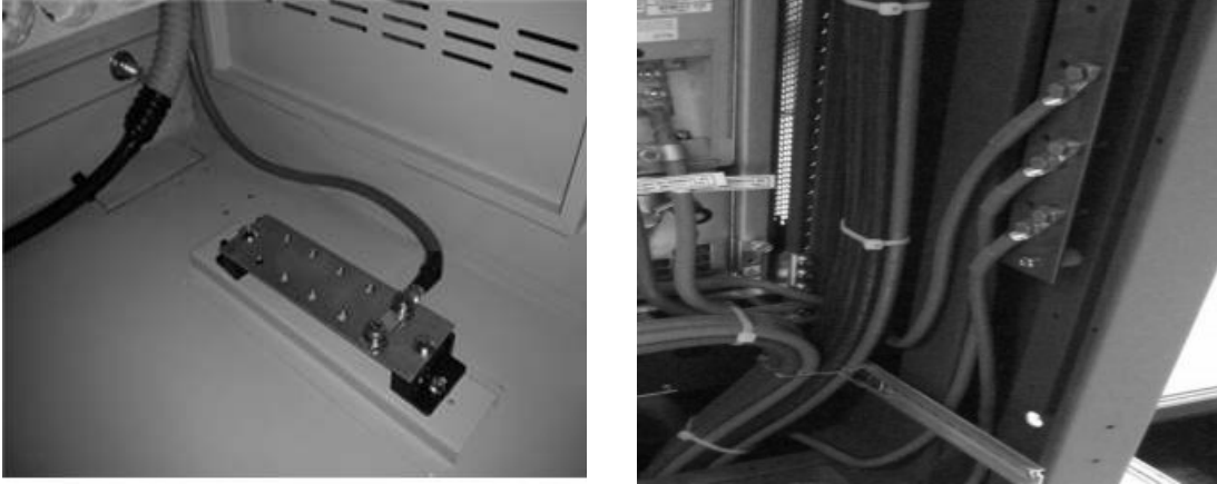
[그림 4-48] Rack 접지(예시)
