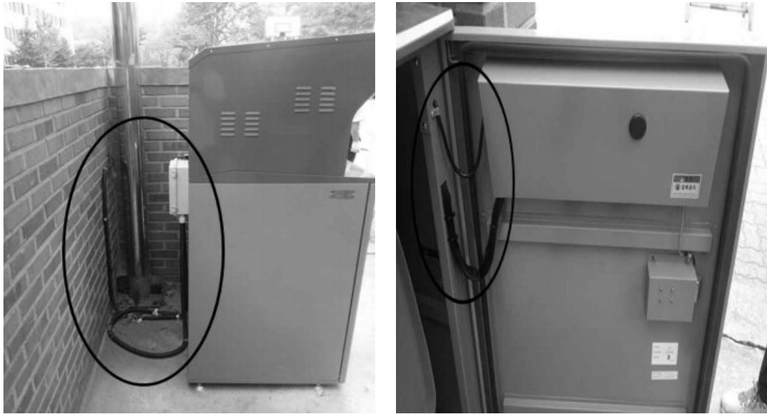
[그림 4-108] 쓰레기종량제시스템 통신케이블 연결완료(예시)
