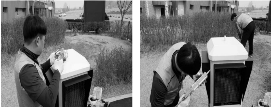
[그림 4-94] 스마트 미세먼지신호등 시스템 방수처리(예시)
