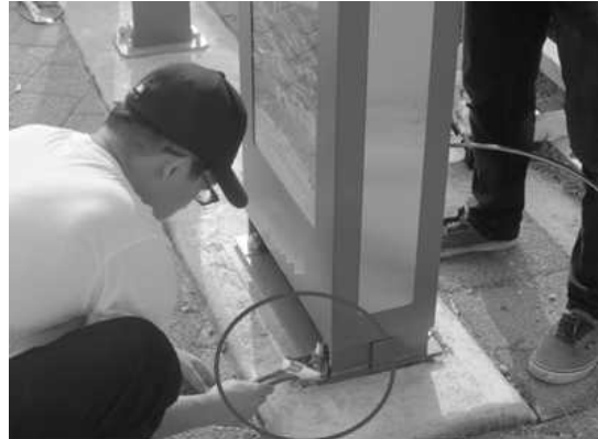
[그림 4-68] 무인대여 자전거 키오스크(Kiosk) 양카볼트 고정(예시)
