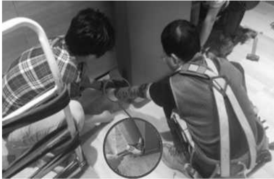
[그림 4-16] 진료시스템 키오스크(Kiosk) 볼트로 고정(예시)
