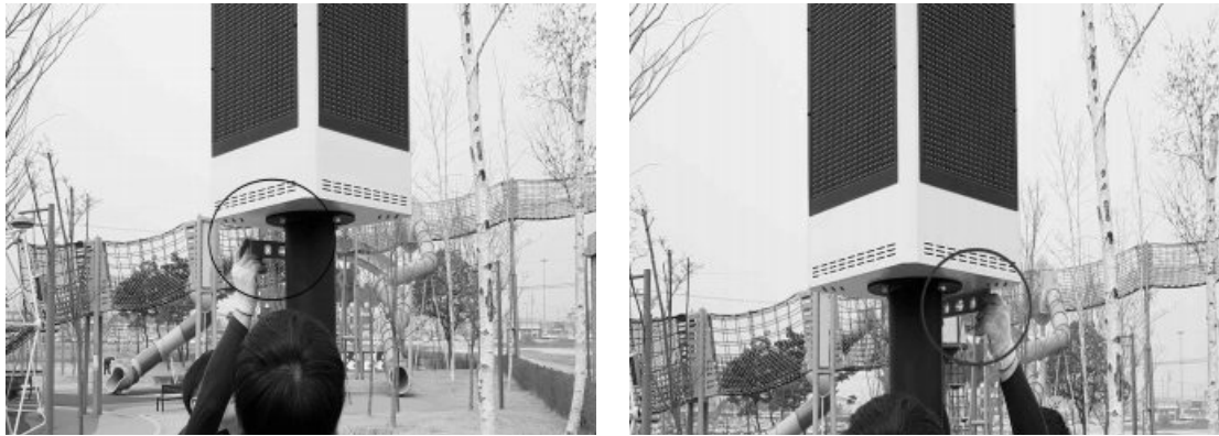
[그림 4-98] 스마트 미세먼지신호등 시스템 수평작업(예시)
