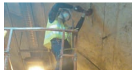
<양카볼트, 클램프 설치>
