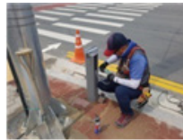
〈센서 Pole 설치〉
