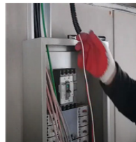
<전력케이블 결선 및 접지 결선>
