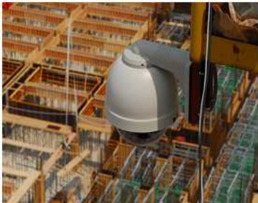
(그림 VI-15) 타워크레인용 CCTV 설치사진
