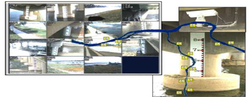
(그림 VI-18) 교량 수위감시 카메라 설치사진
